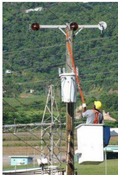
3. ábra Távolból végzett munka szigetelő rúd segítségével [3]
