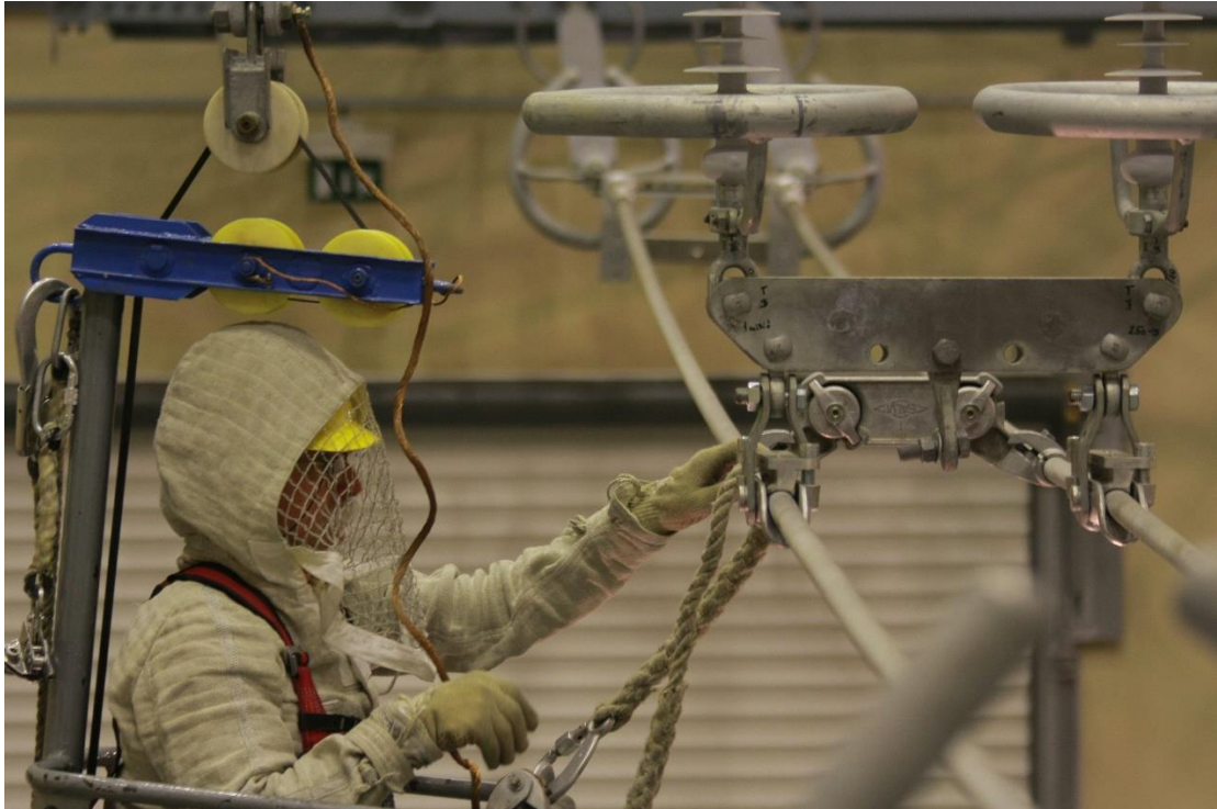
1. ábra Potenciálon végzett munka, bemutató a Nagyfeszültségű Laboratóriumban
