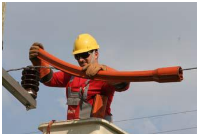
3.2. ábra: Szigetelő tömlő felhelyezése a vezetékre
