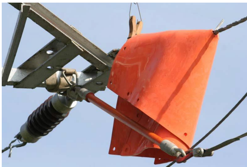
6.3. ábra: hasított lepel használat közben
