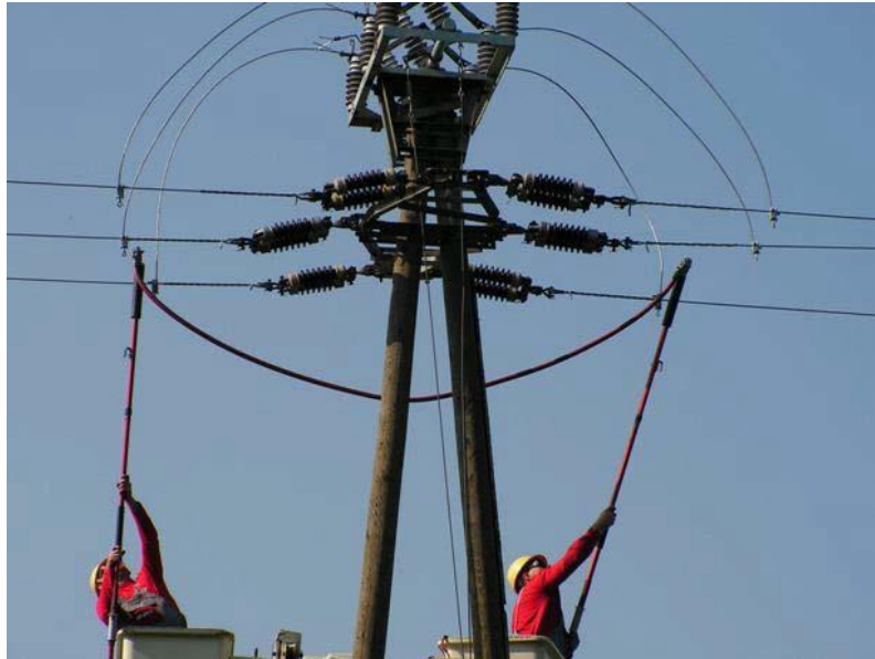
3.3. ábra: Söntkábel felhelyezése horgos szigetelő rudak segítségével
