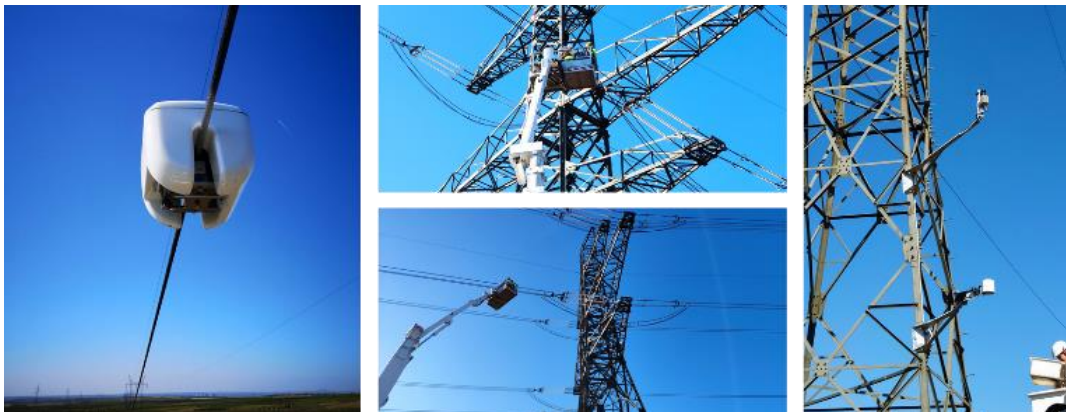
1. Ábra – Pilot DLR megvalósítás egy nagyfeszültségű távvezetéken [4]
