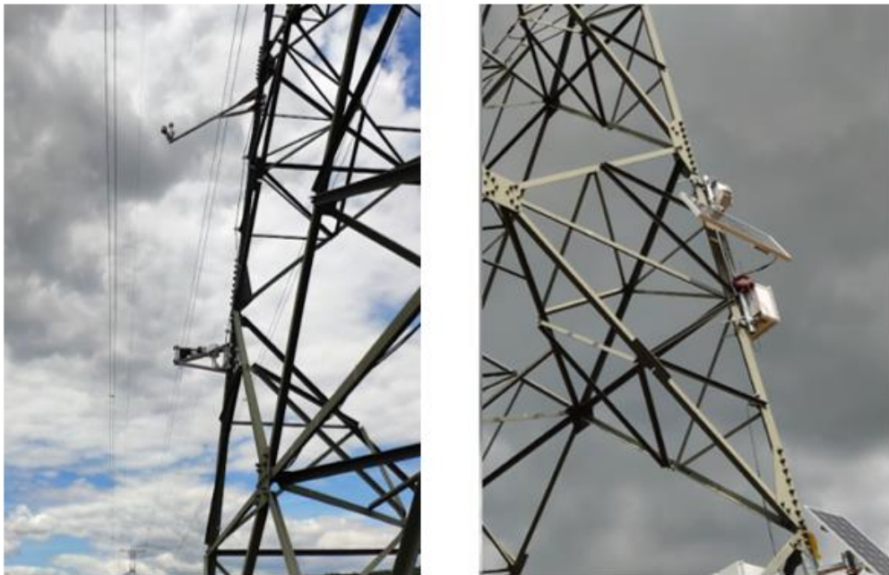
5. ábra - Meteorológiai állomás a távvezeték oszlop szerkezetén a FARCROSS projekt keretében [6]
