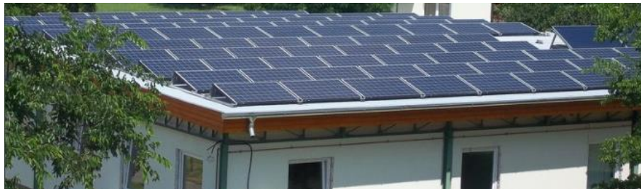
16. ábra: A 22 kW-os rendszer az irodaépület tetején (forrás: ELMŰ)
