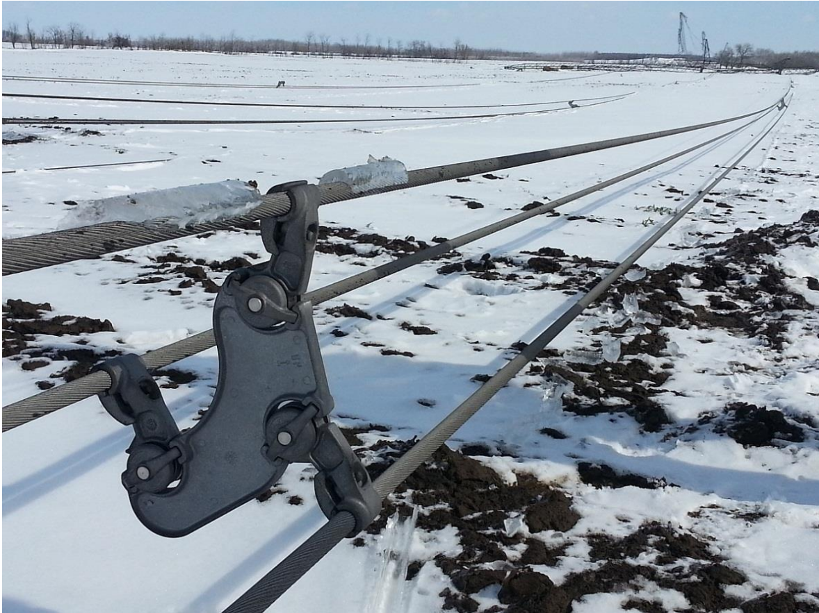
12. ábra: A Munkács-Sajószöged 400 kV-os vonalon a távvezeték sodronyra fagyott, több centiméter vastag jég
