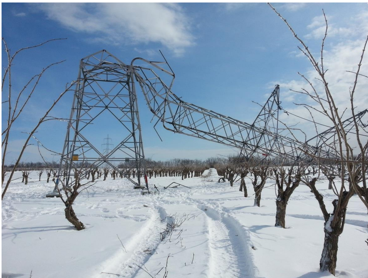
10. ábra: A Kisvárdai-Sajószöged és Munkács-Tiszalök 220 kV-os távvezeték vonalán kidőlt egyik oszlop
