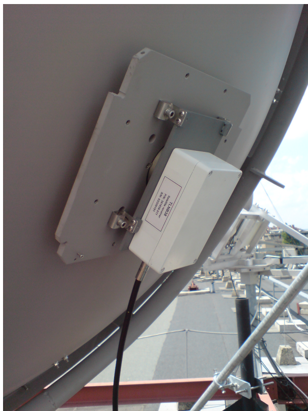
4.2. ábra. Az LNB, felszerelve műholdvételekre - forrás: [7]
