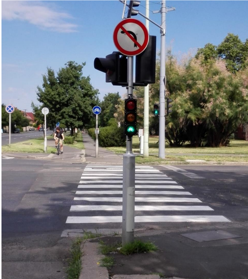
8. ábra: Kerékpáros átvezetés felfestés nélküli gyalogátkelőhely (forrás: saját fénykép)
