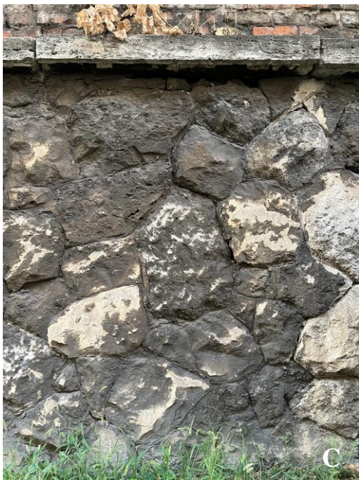
40. ábra: A Kolozsvári utca 47. számnál található mészkő falazat (A, B, C), a mintavételi pontok sematikus rajzon ábrázolva (D)
