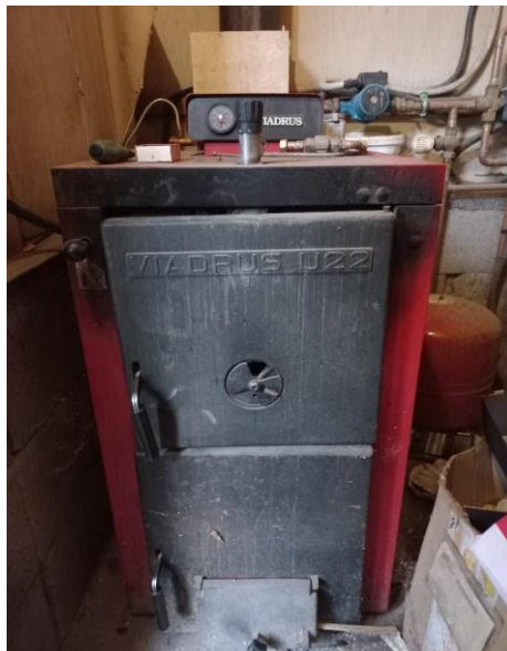
3. ábra Viadrus U22-es típusú vegyestüzelésű kazán
