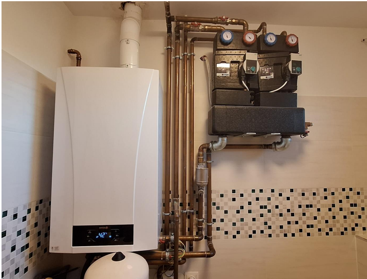
7. ábra Brötje Heizung PWHC típusú gázkazán
