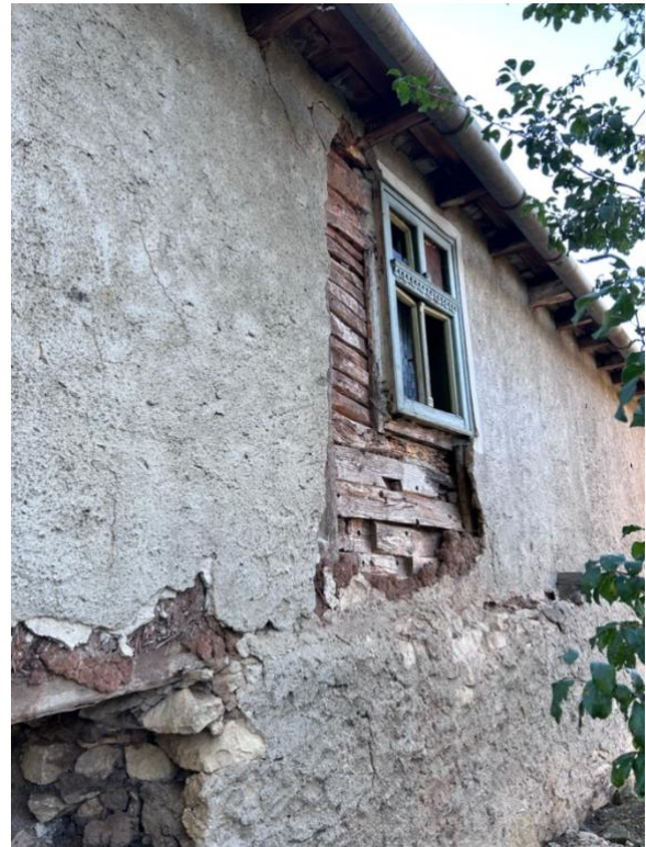
12. ábra: Inaktelke 79. zsilipelt falszerkezete vélhetően újra felhasznált elemekből forrás: Szerzők, 2023
