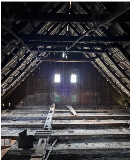
24. ábra: Inaktelke 9. szarusoros, fogópáros fedélszék forrás: Szerzők, 2023
