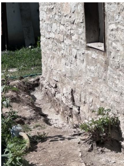
9. ábra: Inaktelke 144. alapozásának feltárása fotó: Szerzők, 2023
