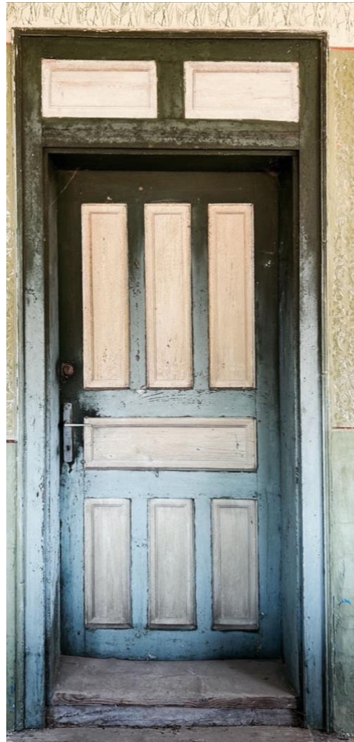
18. ábra: Inaktelke 9 emeleti bejárati ajtó forrás: Szerzők, 2023
