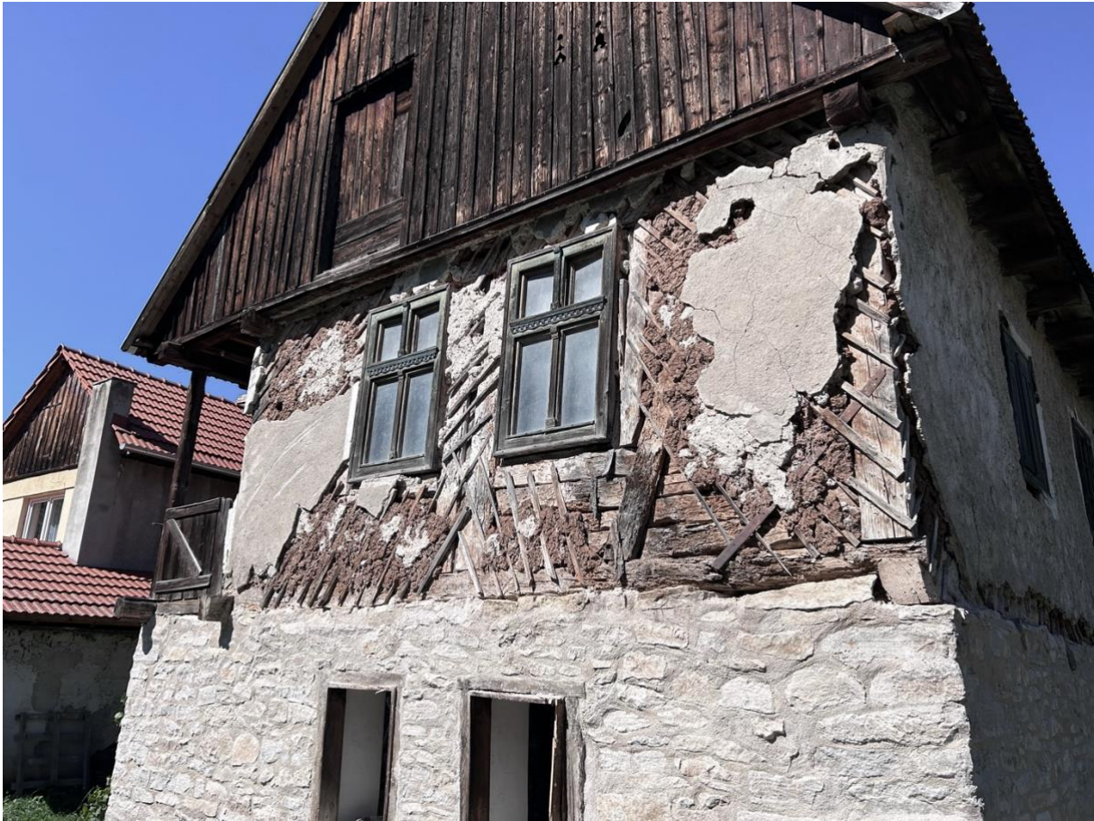
10. ábra: Inaktelke 144 zsilipelt falszerkezete forrás: Szerzők, 2023
