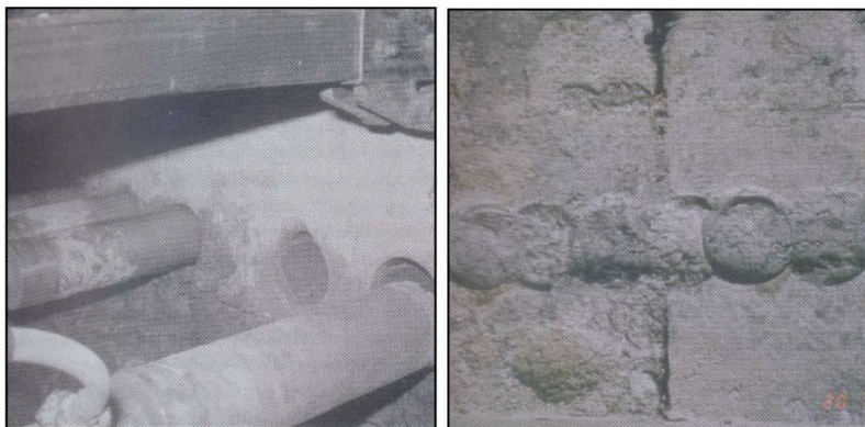
56. ábra: Massari-féle furatkiöntéses szigetelés (17)
