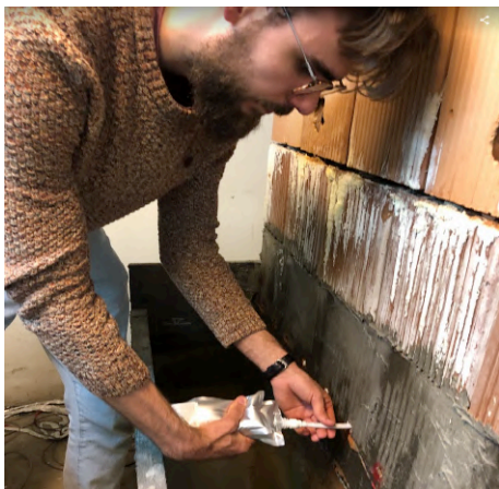
66. ábra: Injektálókrem alkalmazása
