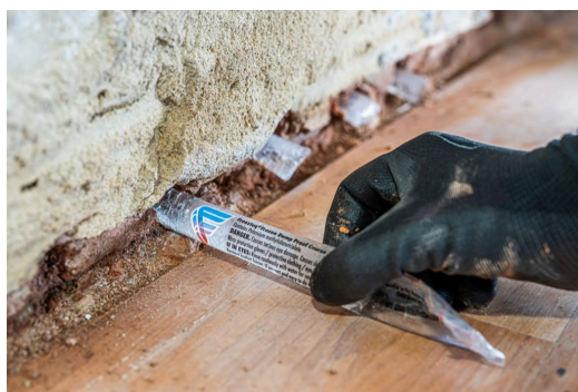
69. ábra: Fagyasztott vegyi anyag rudak behelyezése furatba (28)
