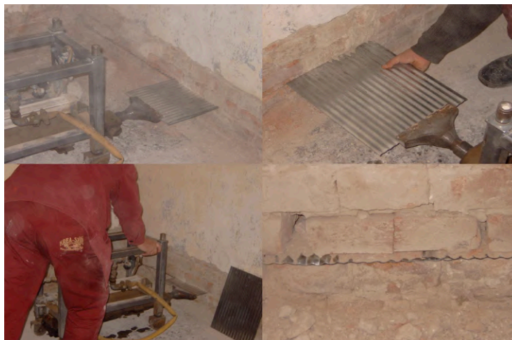
63. ábra: Acéllemez beverésének kivitelezési fotói (26)
