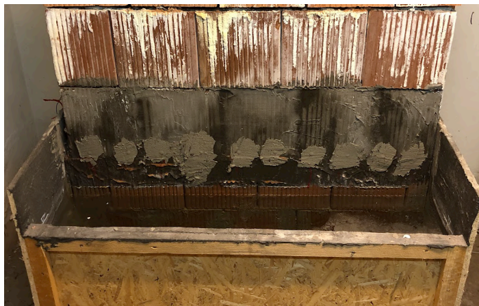
67. ábra: A furatok lezárása cemenhabarccsal
