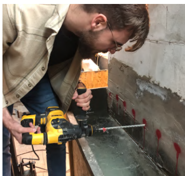
8. ábra: Furatolás kivitelezése
