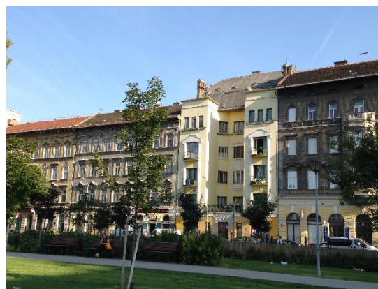
3. ábra: Az összefüggő homlokzatrendszert megbontja az épület beugró szakasza.
