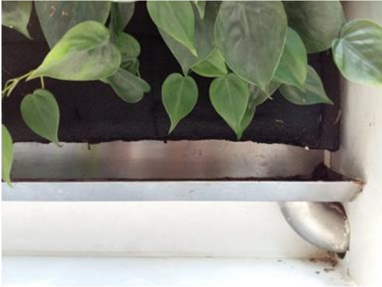
7. Filcnemez a hátszerkezeten, ill. vízvezetési megoldás, saját kép
