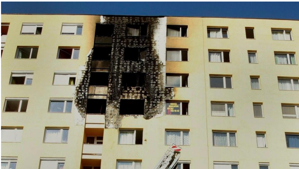
11. Kép a 2009-es miskolci tüzesetről. A tűzterjedés útja jól látható. Forrás: http://24.hu/belfold/2016/10/06/felmentettek-a-miskolci-paneltuz-miatt-megvadolt-not/
