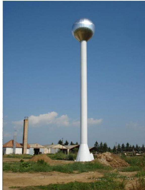
6.3.1 ábra Kikötött gömbcsuklós (Hg típusú) és befogott (Ak típusú) víztorony
