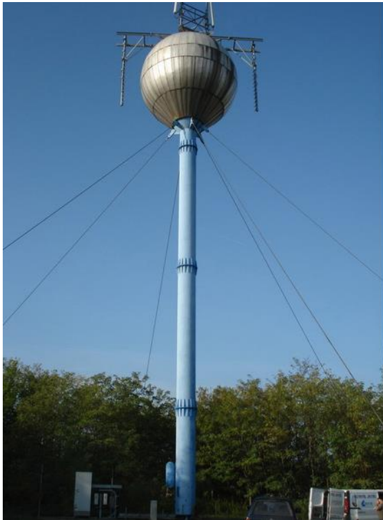
6.3.1 ábra Kikötött gömbcsuklós (Hg típusú) és befogott (Ak típusú) víztorony
