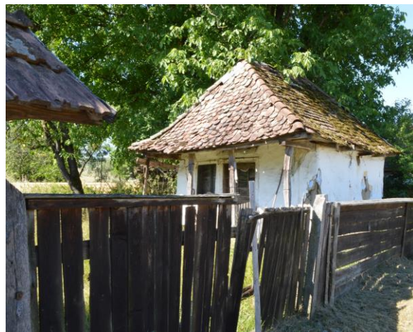
Eredeti kapu és kerítés, megtartott épület
