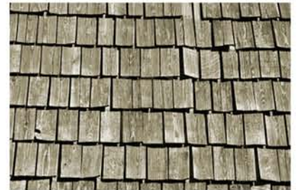
hagyományos deszka és zindelyfedés, ácsszerkezetek
