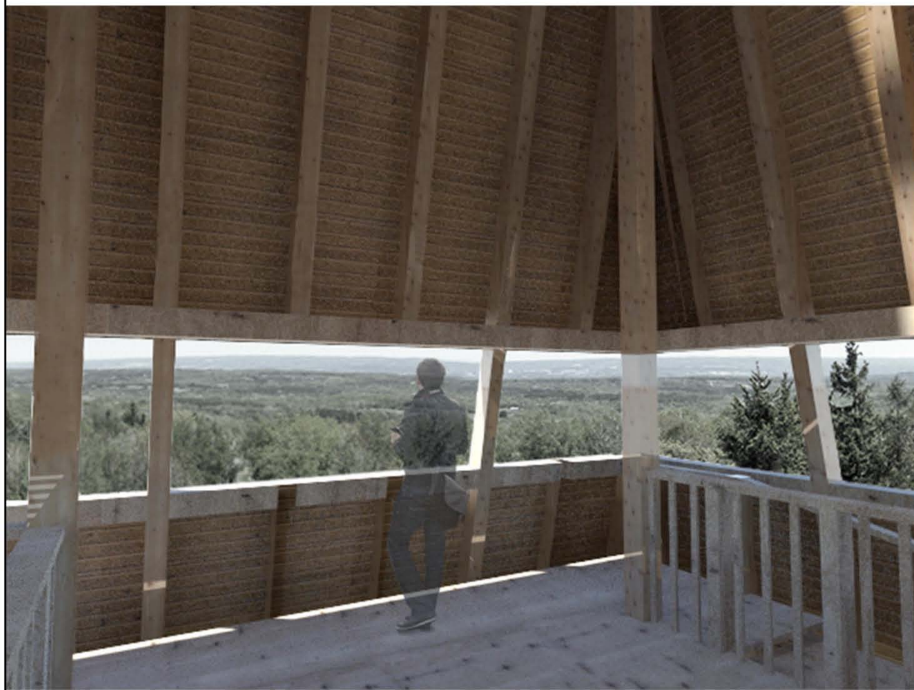
SZÉKOSZLOPOKKAL GYÁMOLÍTOTT SZELEMEN-KERETEK
