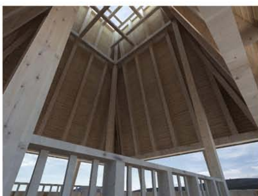
Szaruzat, deszkázat, zindelyborítás
