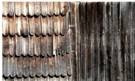
hagyományos deszka és zindelyfedés, ácsszerkezetek
