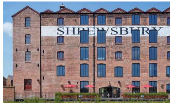
43. fotó Az épület homlokzata
