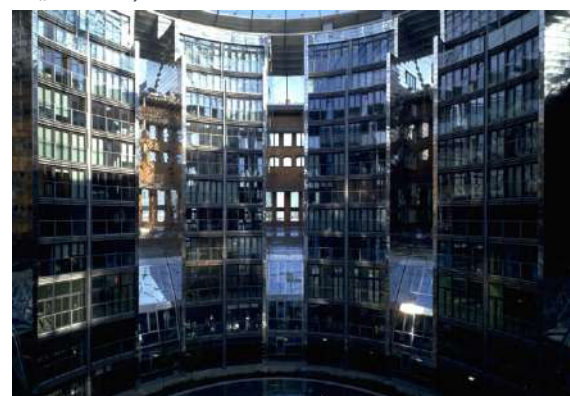
32. fotó Az „A” tartály belső homlokzata
