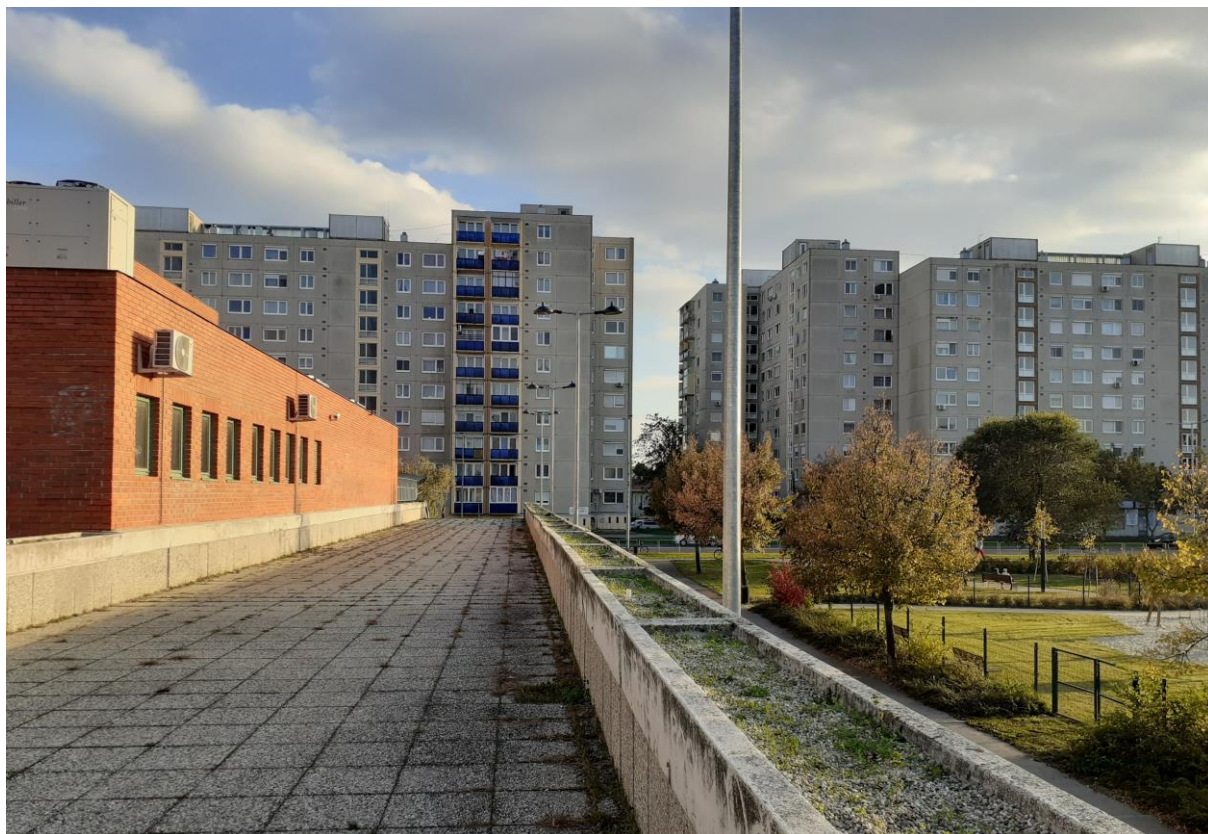
23. ábra: Telefonközpont melletti emelt köztér
