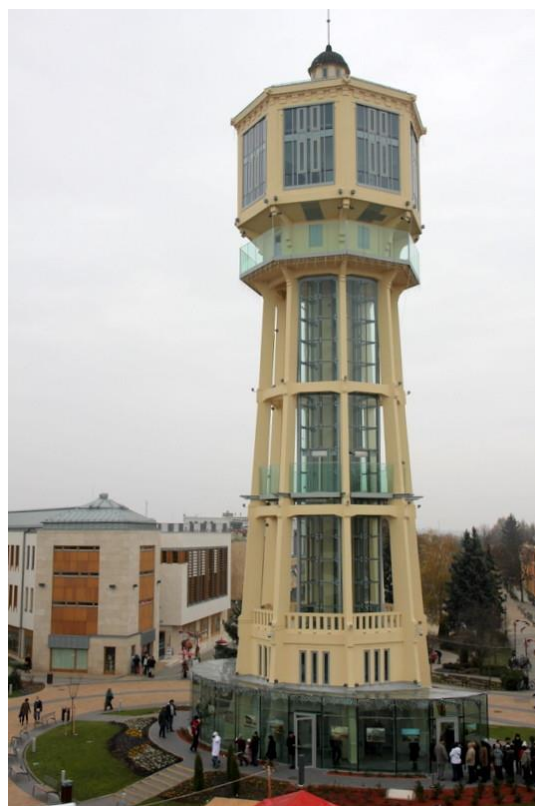
14.kép – A megvalósult víztorony távlati képe/2 http://www.muemlekem.hu/muemlek?id=11403
