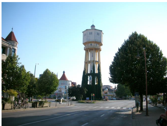
10.kép - Siófoki víztorony a felújítás előtt http://egykor.hu/siofok/308
