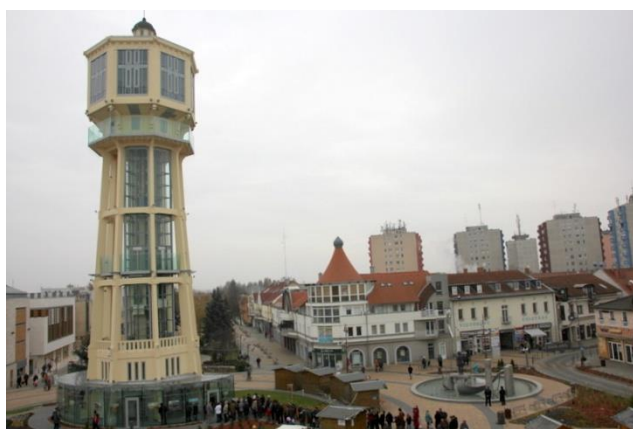
13.kép – A megvalósult víztorony távlati képe http://www.muemlekem.hu/muemlek?id=11403
