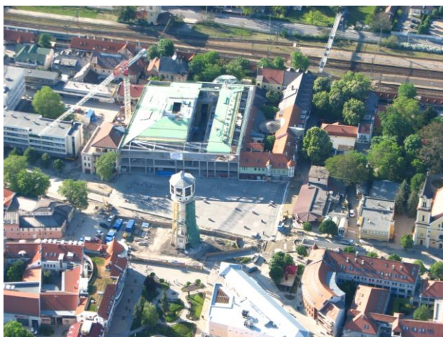
16.kép – Fő tér a felújítás közben http://static.panoramio.com/photos/original/52229830.jpg
