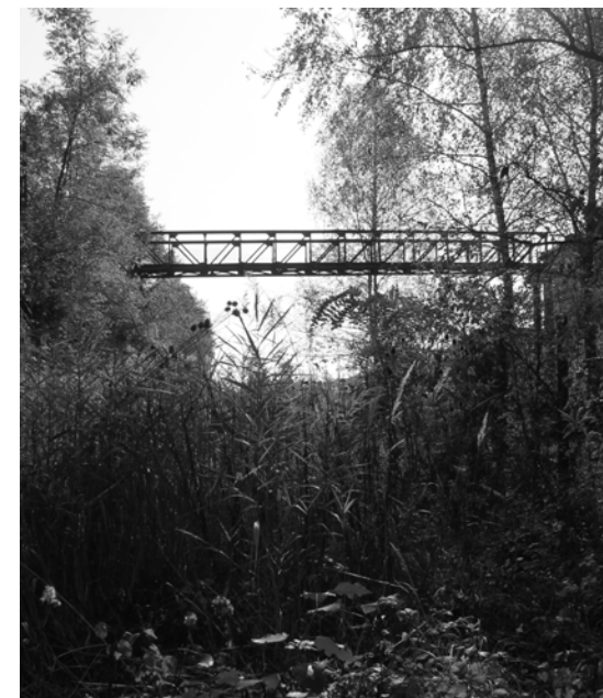
Az altáró bejázatához vezető híd
