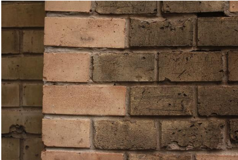
A homlokzat kipótolt sárga téglái 24
