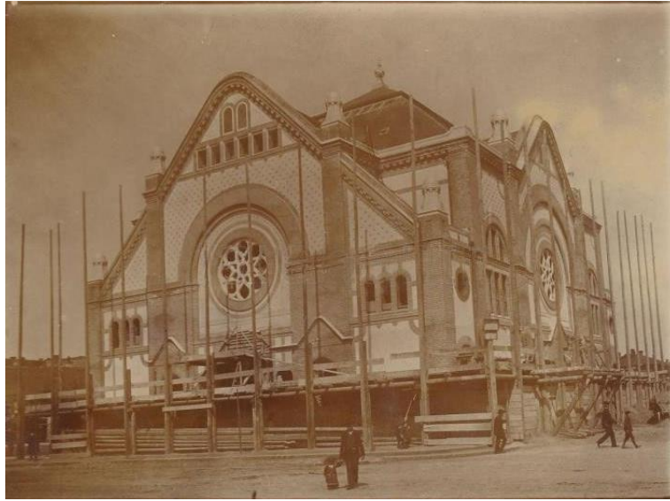
A Dózsa György úti zsinagóga építése 1909 körül 9
