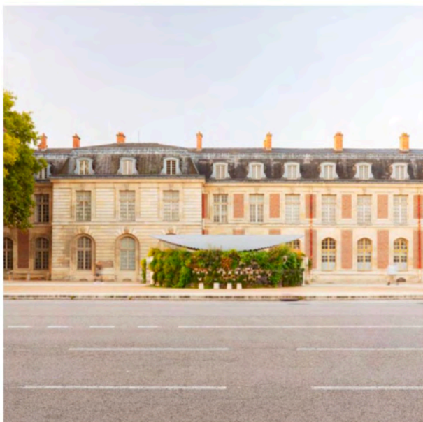
BAPI pavilion, Versailles, 2022, chaltier dalix architectes.
