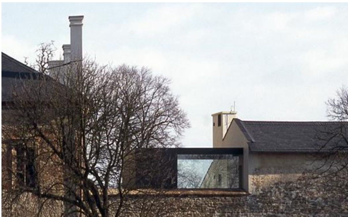
HŠH architekti Érseki múzeum felújítása Olomouc 2000-2006
