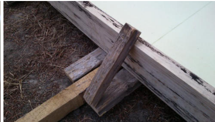
8. kép: Az oldaldeszka kiegészítő merevítése
