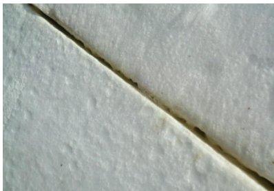
14. kép: Az EPS tábla jellegzetes fugája: porózus felület, gömbölyű élek, részleges vízdugó kialakulása
