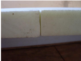
7. kép: A nullhözág zárási tökéletlensége 4 cm XPS táblánál
