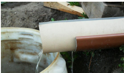
16. kép: A hátoldali és a felületen folyóvíz szétválasztásához beillesztett PVC fólia
