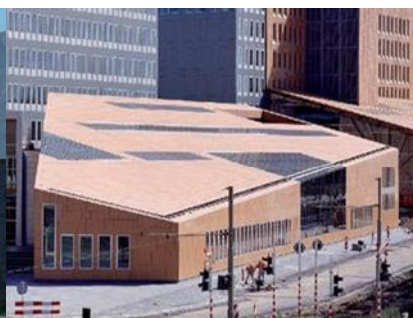
5.kép Eternit Mono Cover épülete
