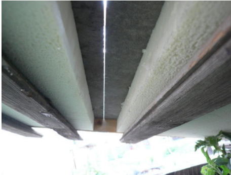
18. kép: A fémlemez fugája alulról fotózva a vízdugóval: az alsó felület teljesen száraz
