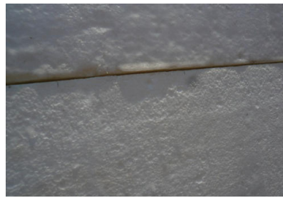
15. kép: Az XPS tábla jellegzetes fugaképe az élek mentén kialakuló víztorlódással
