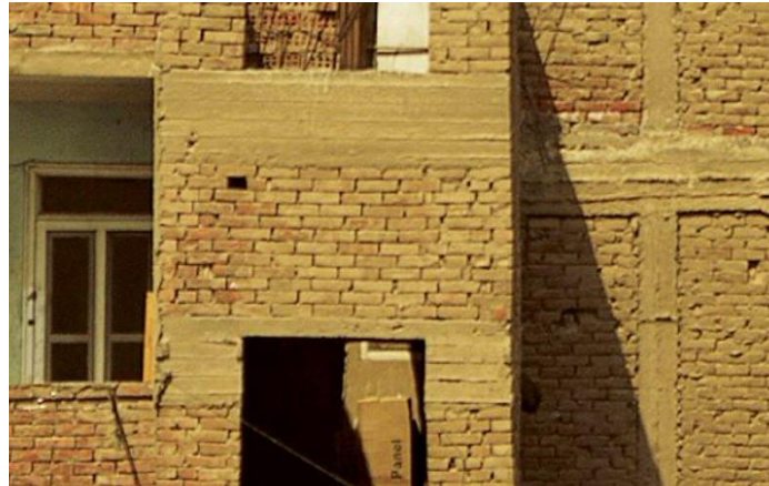
Anyaghasználat: természetes anyagú fedés, vasbeton és vályog
