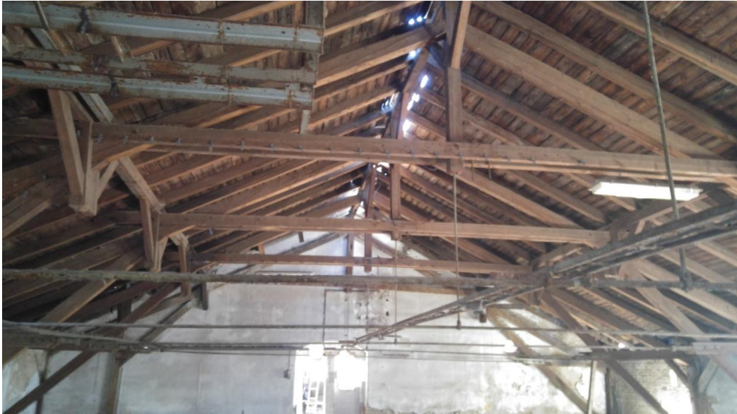
26. ábra Csonkolt ötállószerű fedélszék a középső traktusban
