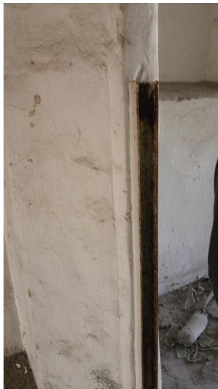
19. ábra Ilyen sínbe helyezték az acéllapot, mikor az árpát elzárták
