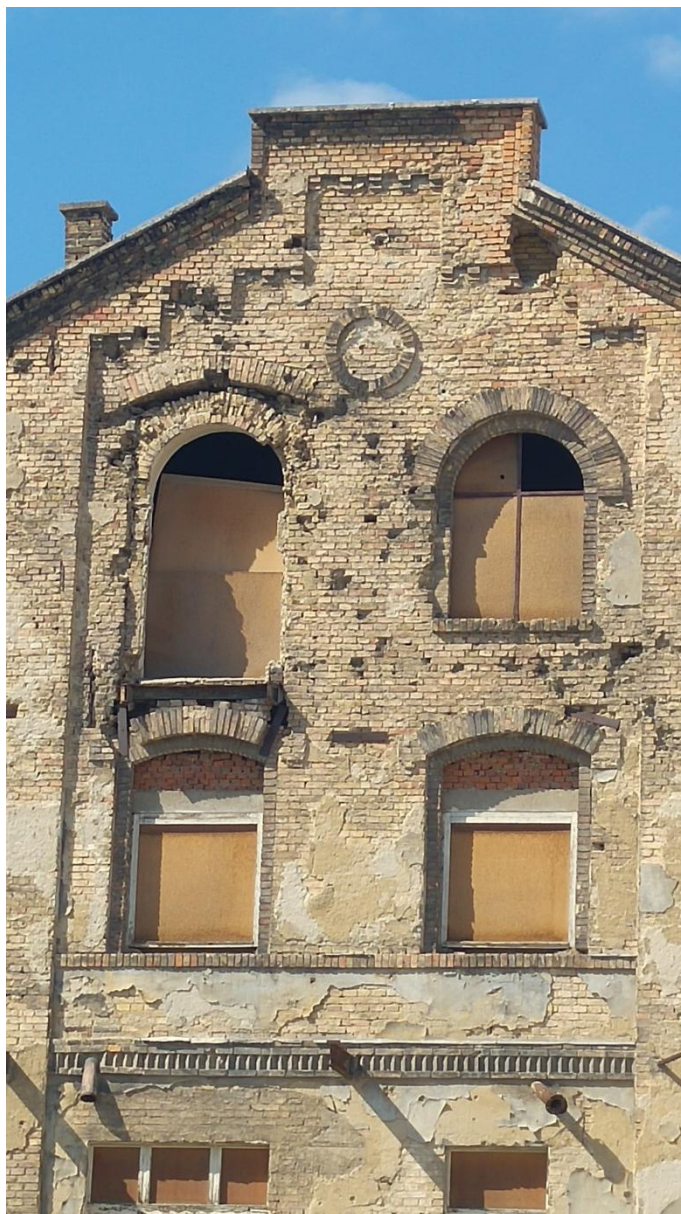
18. ábra Bal felső parapetnélküli ablakon át érkezett az árpa a malátázóba
