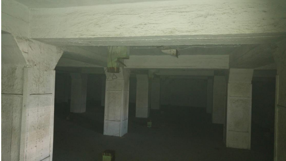
24. ábra Bordarácsos acélbeton födém az 1910-es évekből
