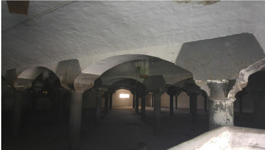
22. ábra Kehelyfejes öntöttvas oszlopok kelyhei fogják be a dongaboltozatot
