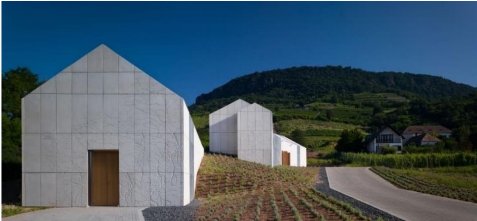
35. ábra Laposa Bazaltbor Borászat – Badacsonytomaj, (kép forrása: https://epiteszforum.hu/bazaltbor-laposa-pinceszeti ), problémakör: rejtett vízvezetés, homogén átforduló tető és homlokzatburkolat
