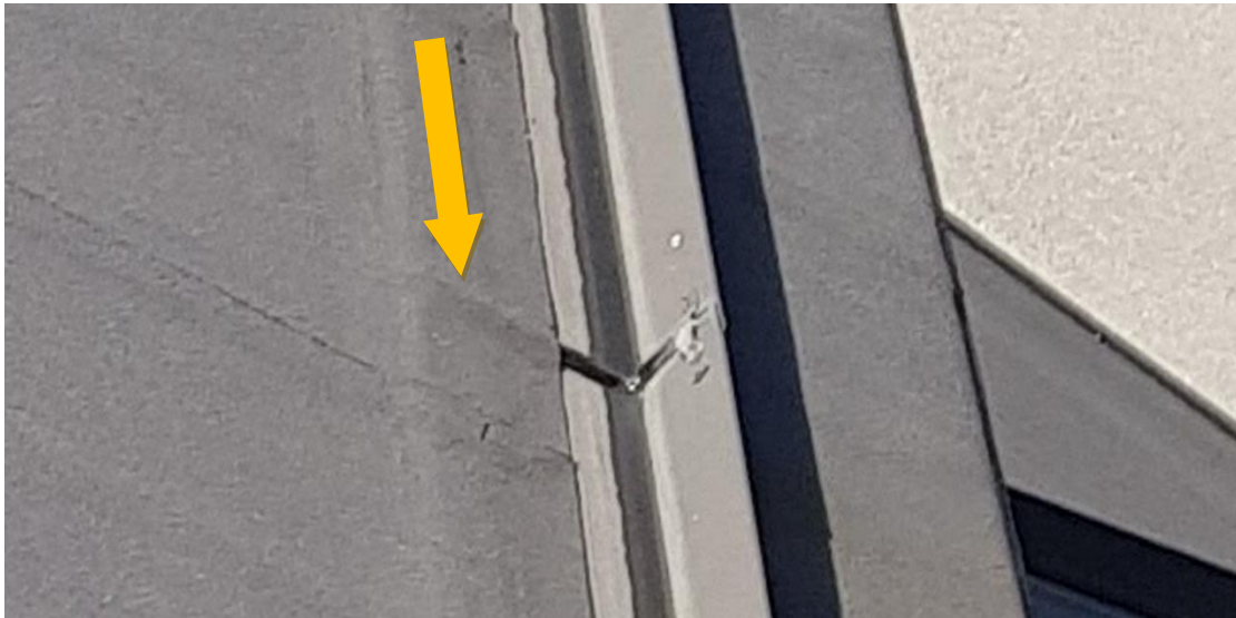
27. ábra VitraHaus, Fekvő ereszt toldása (fotót készítette: Heincz Dániel, ereszlejtésének irányát a nyíl jelzi)
