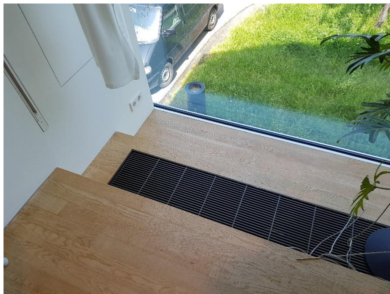
21. ábra VitraHaus, padló lelépcsőzése függönyfalnál (képet készítette: Heincz Dániel)
