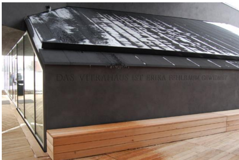
19. ábra VitraHaus, tető télen (forrás: https://www.designboom.com/architecture/herzog-and-de-meuron-vitrahaus-exterior/ )
