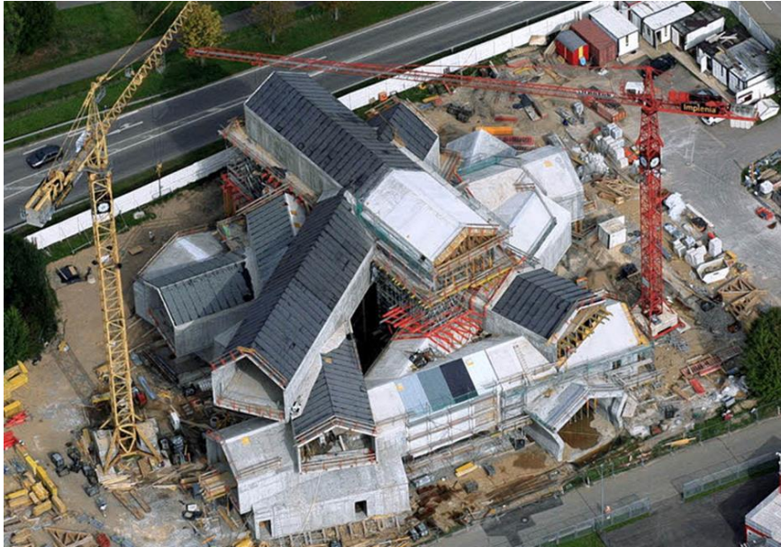
13. ábra VitraHaus építés közben (forrás: https://en.wikiarquitectura.com/building/vitrahaus/ )
