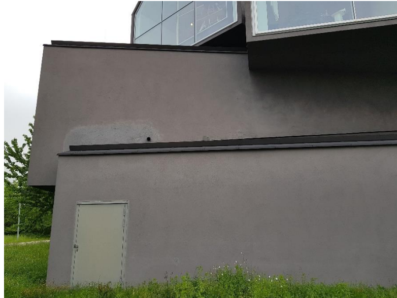
22. ábra VitraHaus lefolyócső kivezetése alsóbb tetőre (képet készítette: Heincz Dániel)
