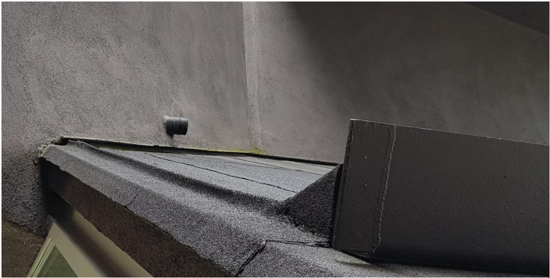
23. ábra VitraHaus, mohásodás falszegély felett, oromszegély és fekvőeresz (képet készítette: Heincz Dániel)
