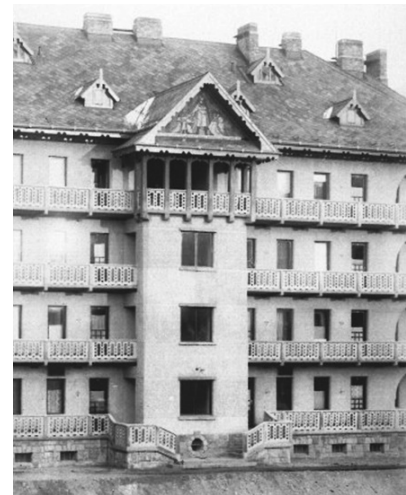
18. Budaörsi út, felső ház függőfolyosói
