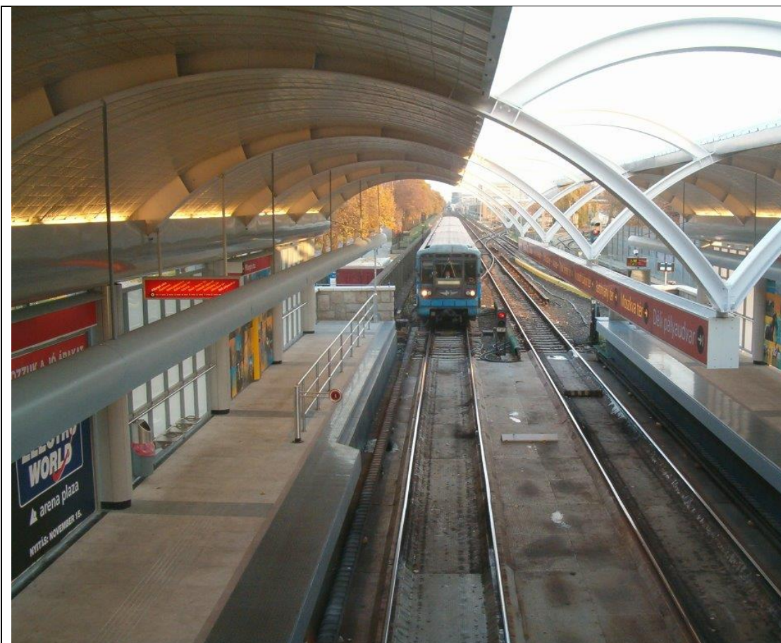
A kettes metró Pillangó utcai megállójának tetőszerkezete
