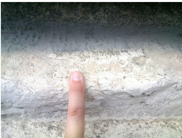
leveles leválás a colmenari mészkő felületén
