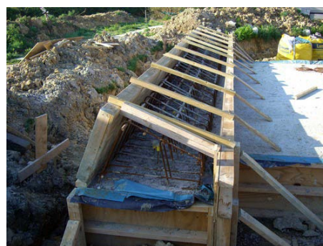
(74) Richard Hawkes Katalán Boltozatának alapozása
