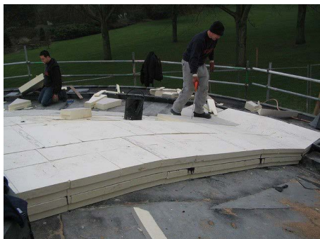
(81) Lapos ívű boltozat szigetelése táblás hőszigeteléssel
