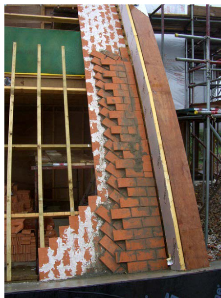
(73) Richard Hawkes lakóháza építés közben
