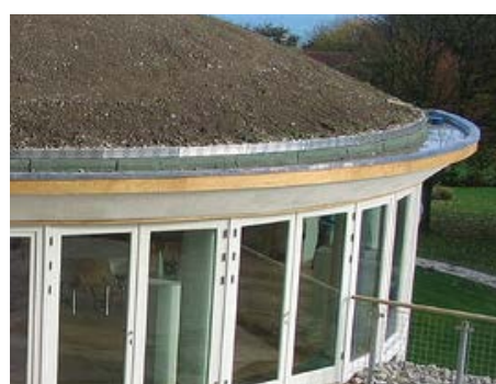
(65) Vízvezetés épített ereszcatornával
