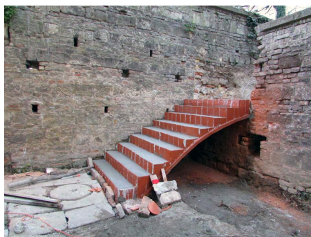
(22) Lépcsőfokok betonnal feltöltve
