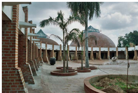
(60) Katalán kupolák vízelvezetése vízköpővel
