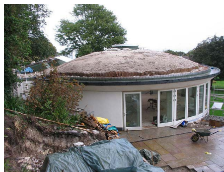
(89) Zöldtetős Katalán Boltozat geocella lefedéssel, benne feltöltés
