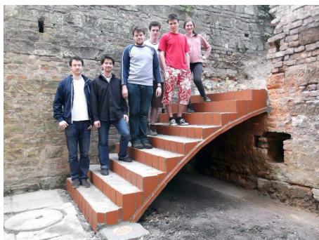
(1) Alkotóhét keretében épített Katalán lépcső
