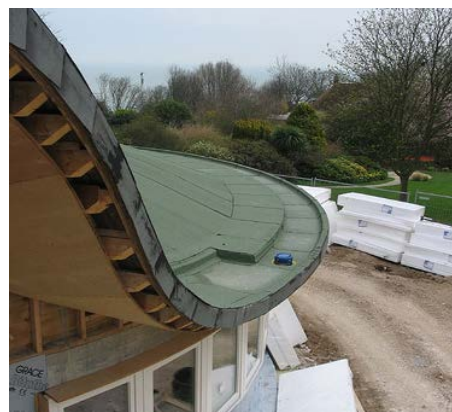
(66) Vízvezetés épített ereszcatornával
