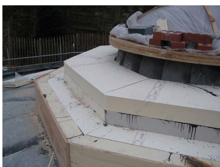
(82) Felülvilágító körbe szigetelése táblás hőszigeteléssel
