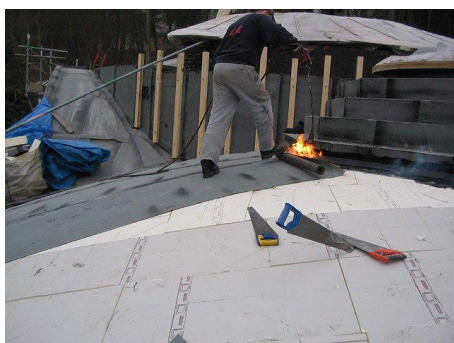
(83) Vízáró membrán lángolvasztása
