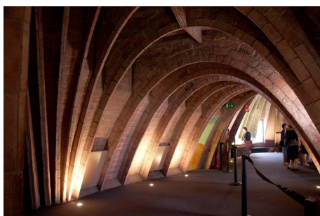
(52) Katalán bordák, mint fedélszék helyettesítő épületszerkezeti elemek
