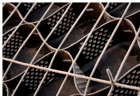
(90) Geocella beépítés részlete – Richard Hawkes lakóháza
