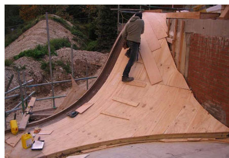
(67) Katalán boltozatok összekötése hajlított rétegeltlemezrel
