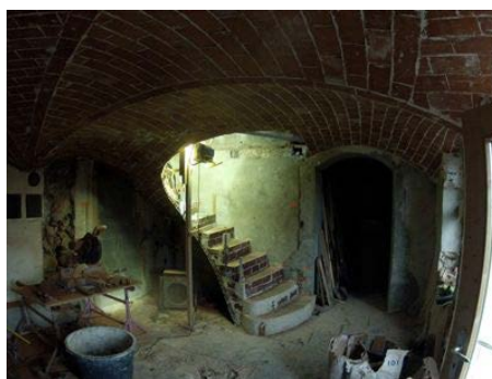
(31) Pittet Artisans fődémmel „egybefolyó” lépcsője kivitelezés közben
