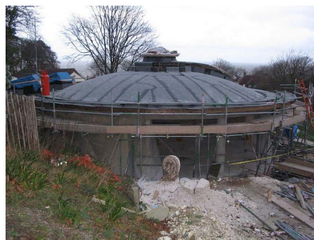
(84) Lapos ívű boltozat vízszigetelése modifikált bitumenes vastaglemezzel
