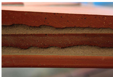
(16) Három rétegű Katalán Boltozat rétegei
