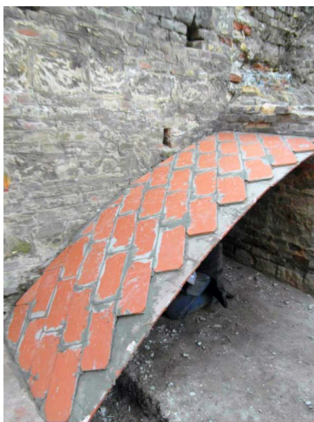
(19) A második réteg 45°-kal elforgatva kerül a szerkezetre
