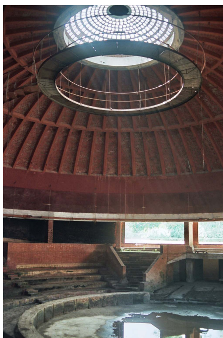
(59) Katalán kupola merevítése bordákkal
