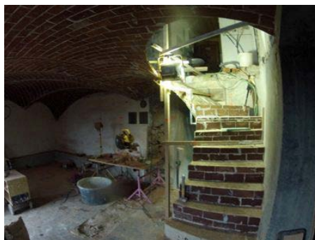
(32) Pittet Artisans fődémmel „egybefolyó” lépcsője kivitelezés közben
