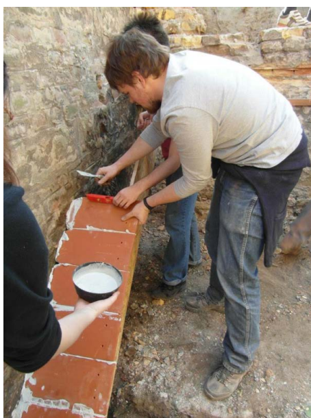
(18) Az első réteg gipszes habarccsal készül, hogy gyorsabban megkössön
