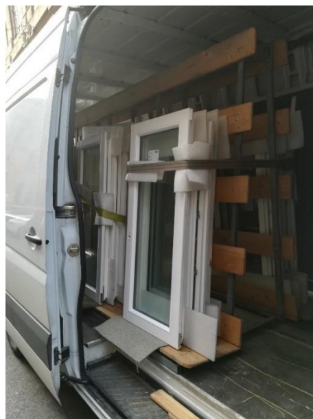
56. ábra A helyszínre szállított ablaktokok és szárnyak Fotó: szerzők, 2020
