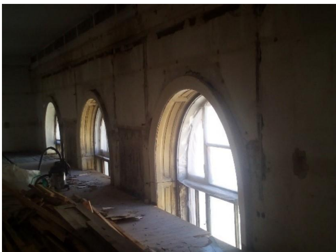
29. ábra Az felső szintű ablakok a próbateremben a parapetborítás és a deszkázat kibontásával, a vékony lemez béléstborítás eltávolítása után, Szerzők, 2020
