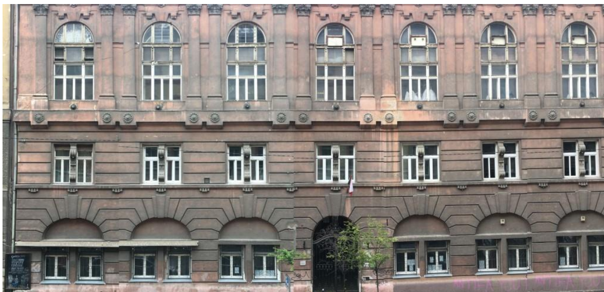
21. ábra: Homlokzati kép a felújítás előtt, Szerzők, 2020
