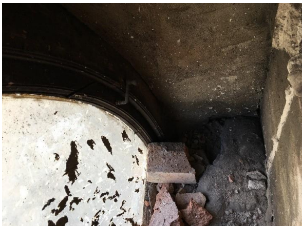
25. ábra Az öltöző elfalazott íves ablaka, kifelé nyíló szárnyal Szerzők, 2020
