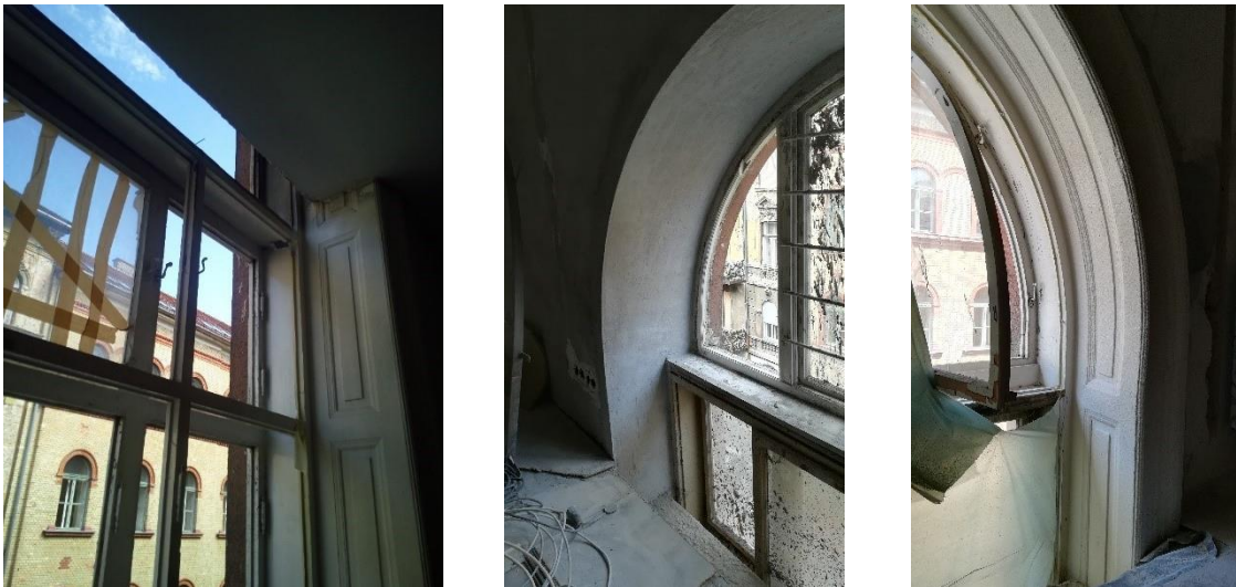
54 ábra Az előkészített ablakok régi ablakszárnyak nélkül, felületkezelt béllettel valamint vakolt belső felülettel Fotó: szerzők, 2020
