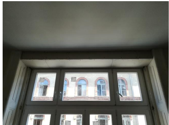
65. ábra A födémhez csatlakozó akusztikai lezárás még nyers, gipszkarton felülettel Fotó: szerzők, 2020
