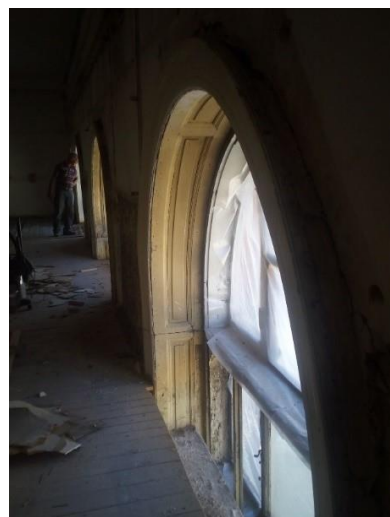
29. ábra Az felső szintű ablakok a próbateremben a parapetborítás és a deszkázat kibontásával, a vékony lemez béléstborítás eltávolítása után, Szerzők, 2020
