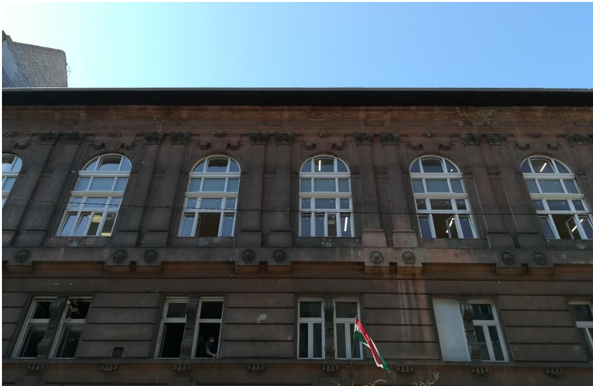
59. ábra Az utcai homlokzat az új nyílászárókkal Fotó: szerzők, 2020
