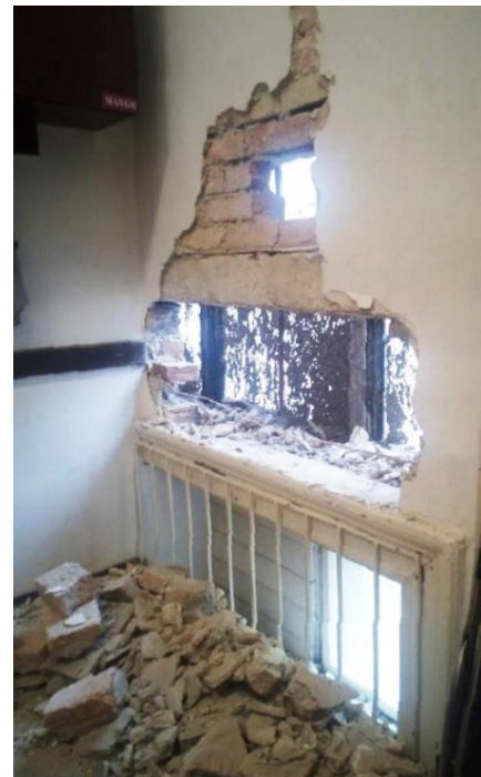
24. ábra: Ablak kibontásának folyamata Szerzők, 2020
