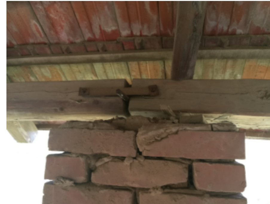
Talpszelemen kialakítása
