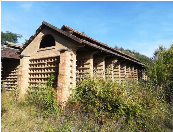
26. ábra: paksi Keller-rendszerű téglaszárító szín, bal: saját fotó, jobb: 3D modell
