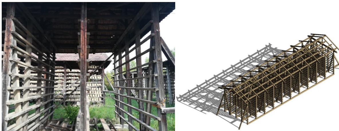
24. ábra: mázai, Keller-rendszerű szárítószín, bal: saját fotó, jobb: 3D modell
