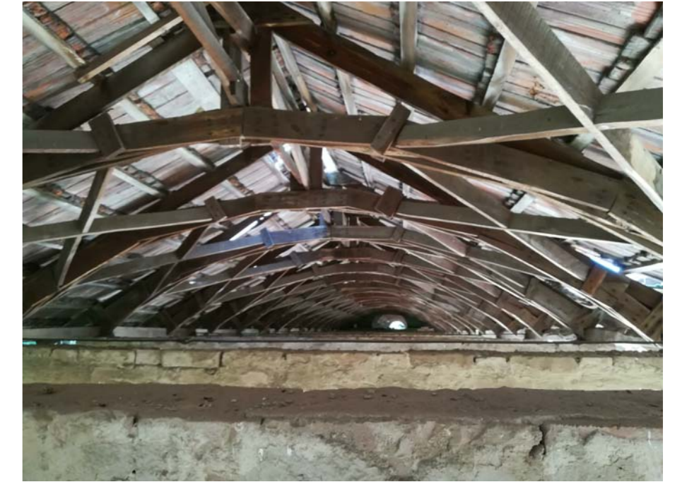
Tetőszerkezet (deszkaíves)
