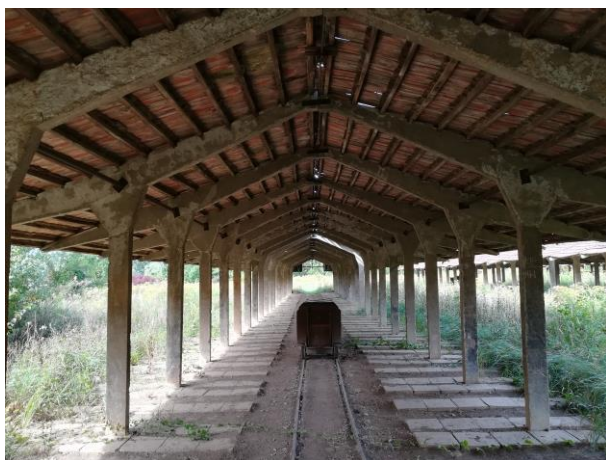
16. ábra: mázai vasbeton szárítósín, bal: saját fotó, jobb: 3D modell
