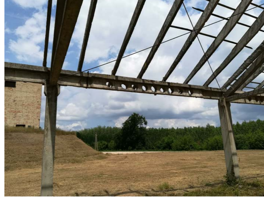
Talpszelemen hosszoldása
