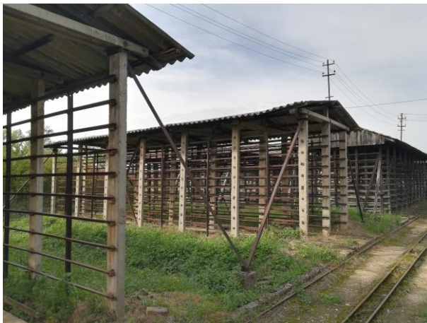
27. ábra: mázai Keller-rendszerű téglaszárító szín, bal: saját fotó, jobb: 3D modell
