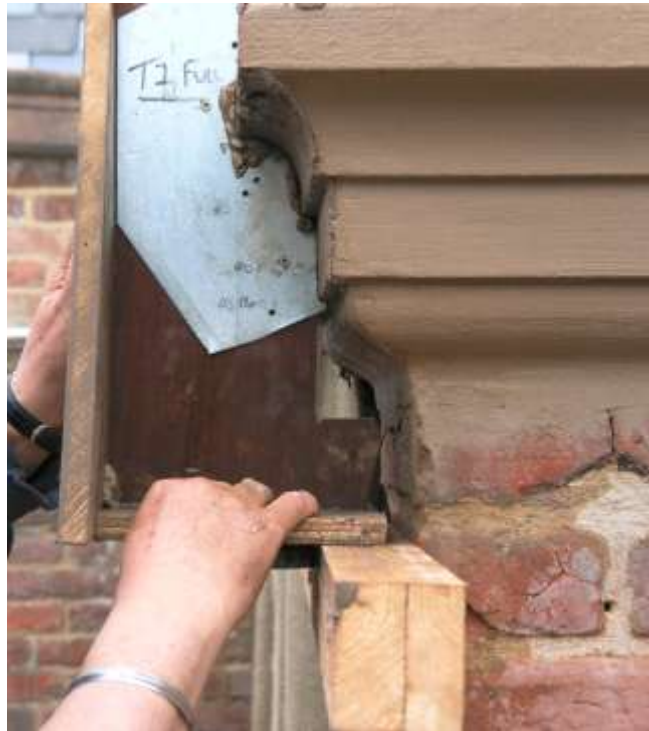
Sarok kialakítás, éles kihúzás vezető- és kísérőlécekkel [34].
