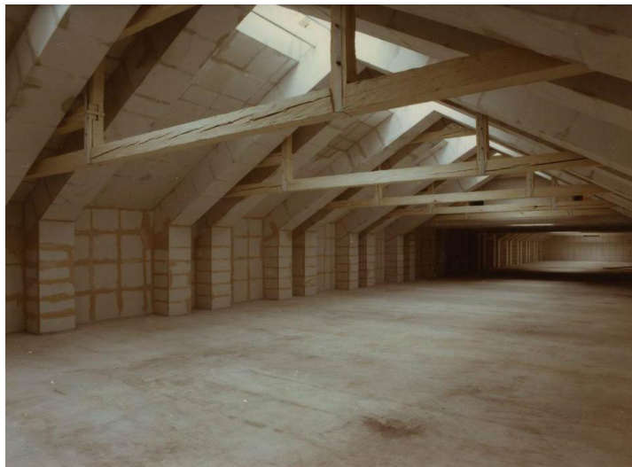
2. kép: A Nemzeti Múzeum tetőterében kialakított raktár gipszbeton szerkezete forrás: [9]
