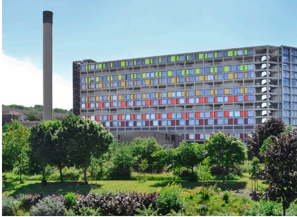
27. ábra: a Park Hill felújított szárnya
