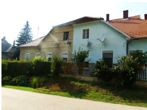
1. kép. Félig felújított lakás
