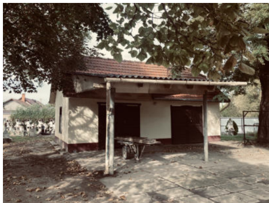
13. ábra. Cegléd, Csengettyűs temető - Ravatalozó. Fotó: Fülöp Helga
