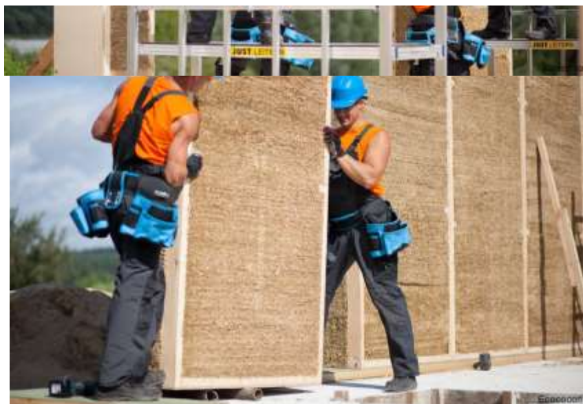
34.ábra előregyártott panelek szerelés közben [8]
