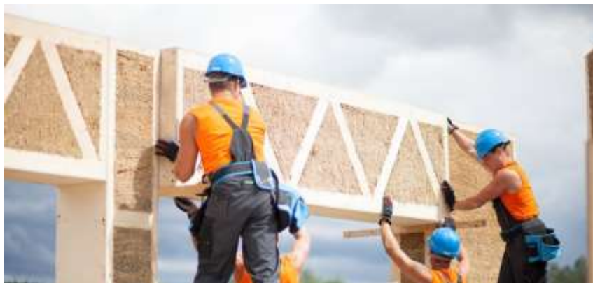
33.ábra előregyártott panelek szerelés közben [8]
