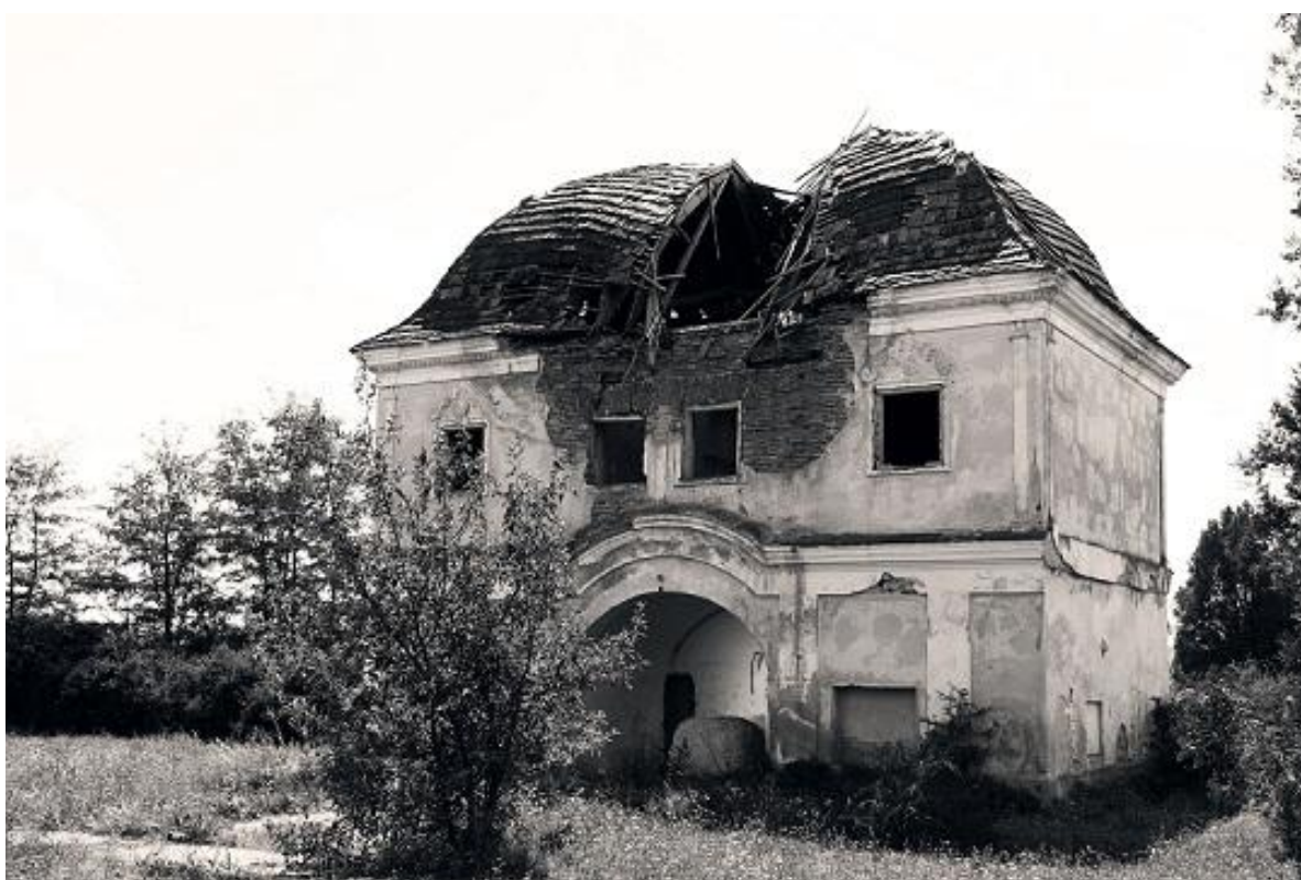
28. kép: A kapuház beomlott tetővel
