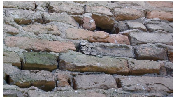
16. kép. Túlégetett téglák a keleti homlokzaton és a belső nyugati falban
