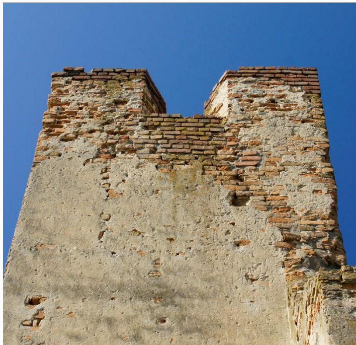
52. kép. Rézsűs ablak a déli homlokzat felső szintjén. Saját fénykép
