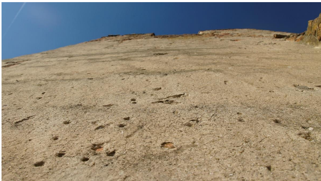
50. kép. Síkbeli különbségek az egyes vakolatrétegek között. Saját fénykép
