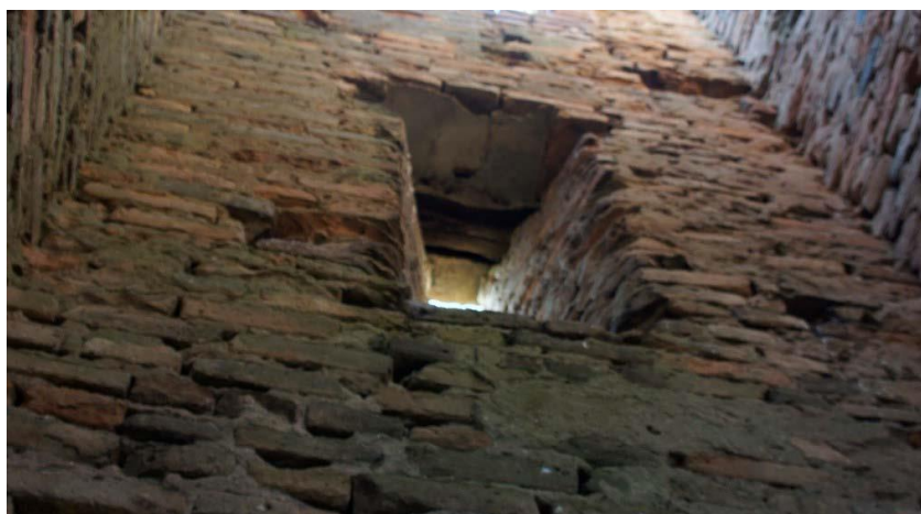
61. kép. Korabeli áthidalógerenda a nyugati oldalon. Saját fénykép
