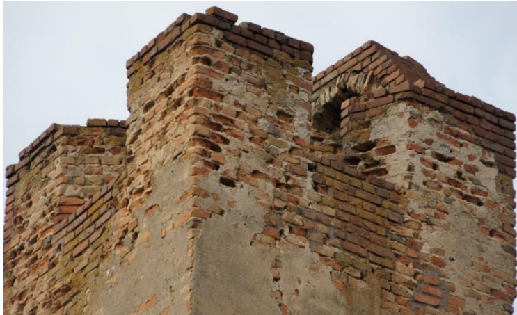
62. kép. Íves falazás a keleti ablak belső részén. Saját fénykép
