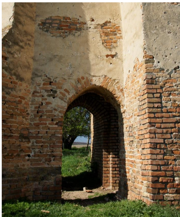
51. kép. Eredeti csúcsíves bejárat nyílás a déli homlokzaton. Saját fénykép
