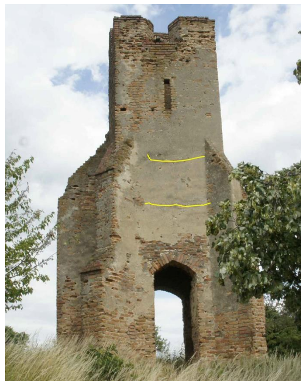
49. kép. A repedés látszik a déli és a nyugati homlokzaton is. Saját fénykép és rajz
