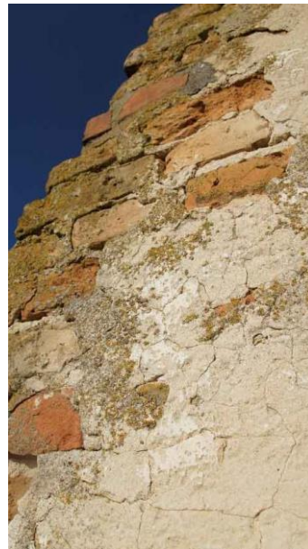
14. kép. Vakolat, és a rajtuk és alattuk is megtalálható meszes réteg. Saját fényképek
