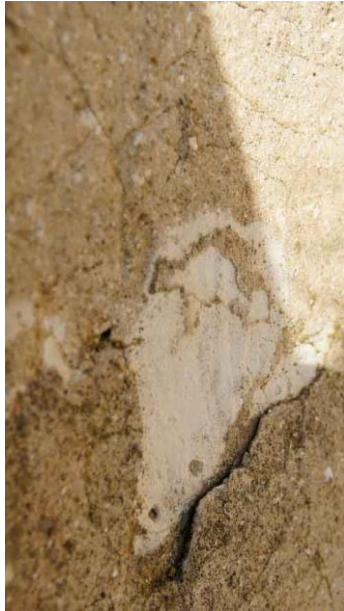
14. kép. Vakolat, és a rajtuk és alattuk is megtalálható meszes réteg. Saját fényképek
