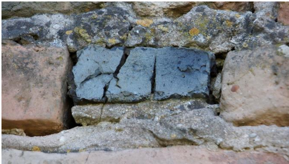
16. kép. Túlégetett téglák a keleti homlokzaton és a belső nyugati falban
