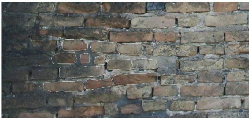
13. kép. Téglasorok egyenetlensége, szétválása. Saját fénykép és rajz
