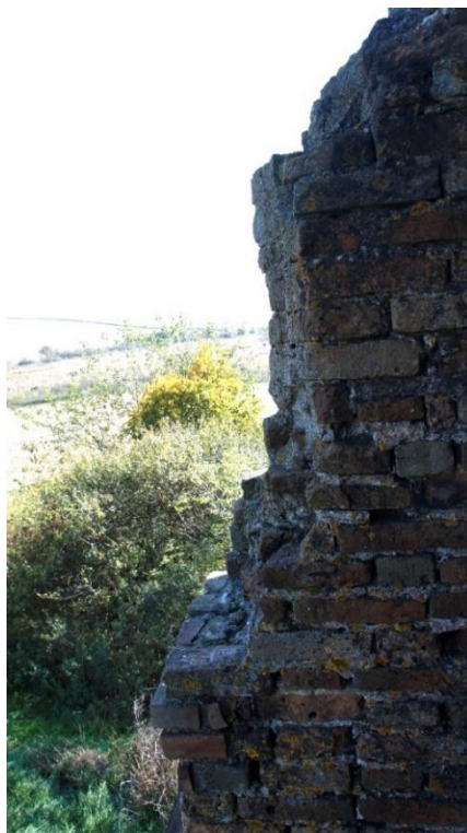
43. kép. Vakolt, sík ablakmaradvány a déli falkezdeményen. Saját fénykép és rajz
