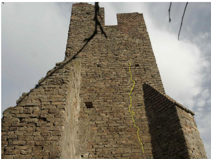
29. kép. A repedés a külső és a belső oldalon. Saját fénykép és rajz
