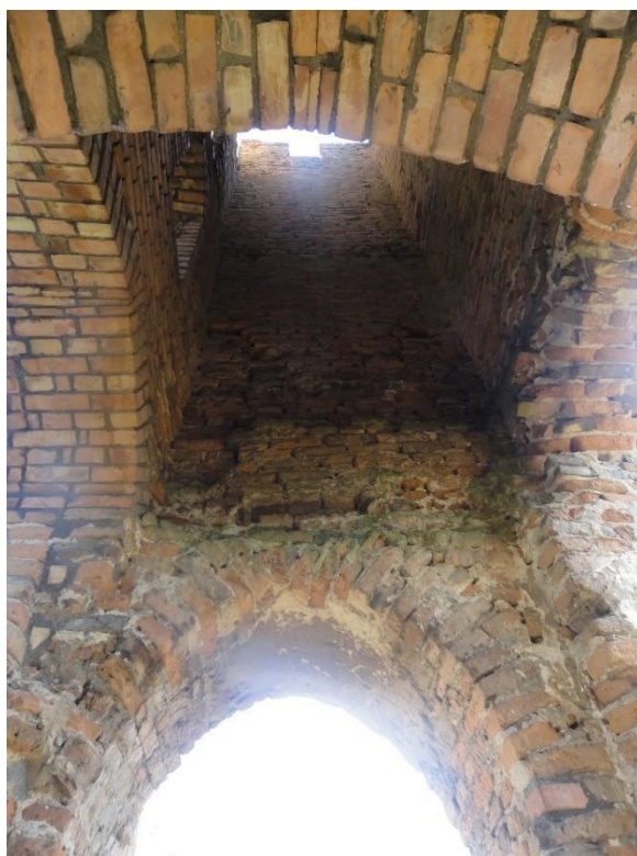
60. kép. Belső falsíkváltások. Saját fénykép
