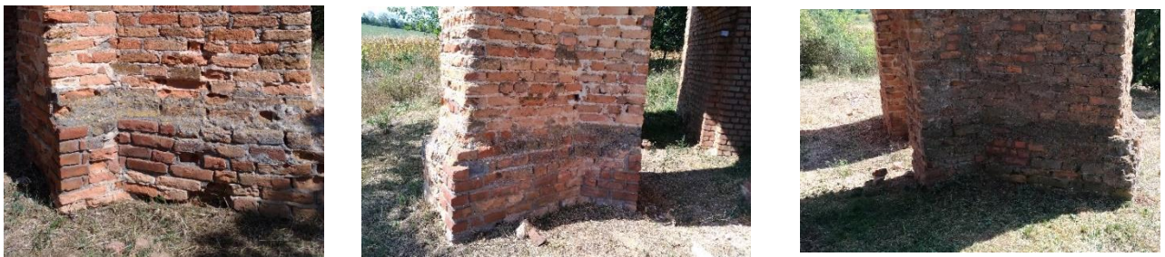
23. kép. Az alsó rézsús kiugrás körbefut. Saját fényképek
