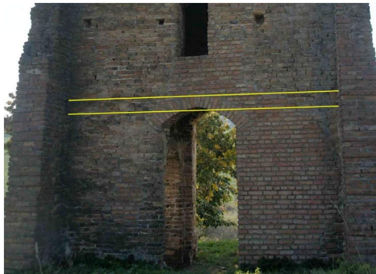
42. kép. A lyukak vonala metszi a nyílás záradékát. Saját fénykép és rajz
