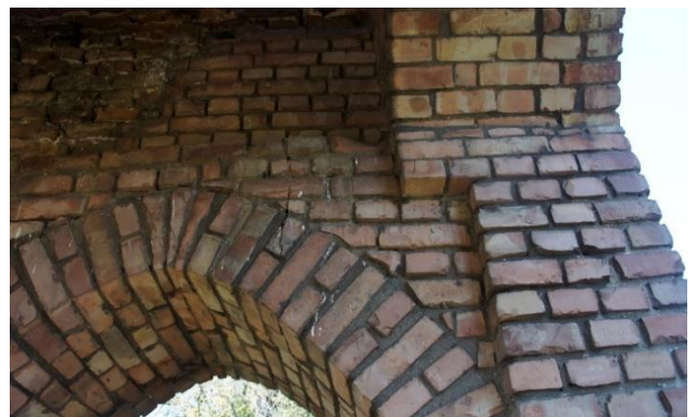
32. kép. Újrafalazott belső rész. Saját fénykép
