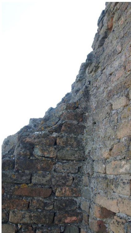
44. kép. Íves habarcsolás a falsarkokon. Saját fénykép
