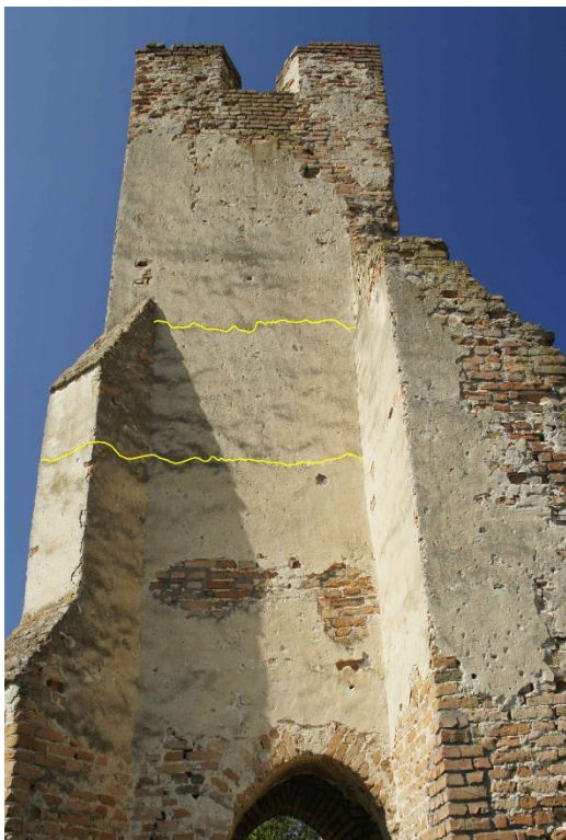
49. kép. A repedés látszik a déli és a nyugati homlokzaton is. Saját fénykép és rajz
