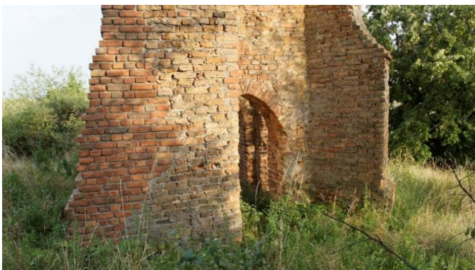
31. kép. Jól elkülönül a két falazás. Saját fénykép
