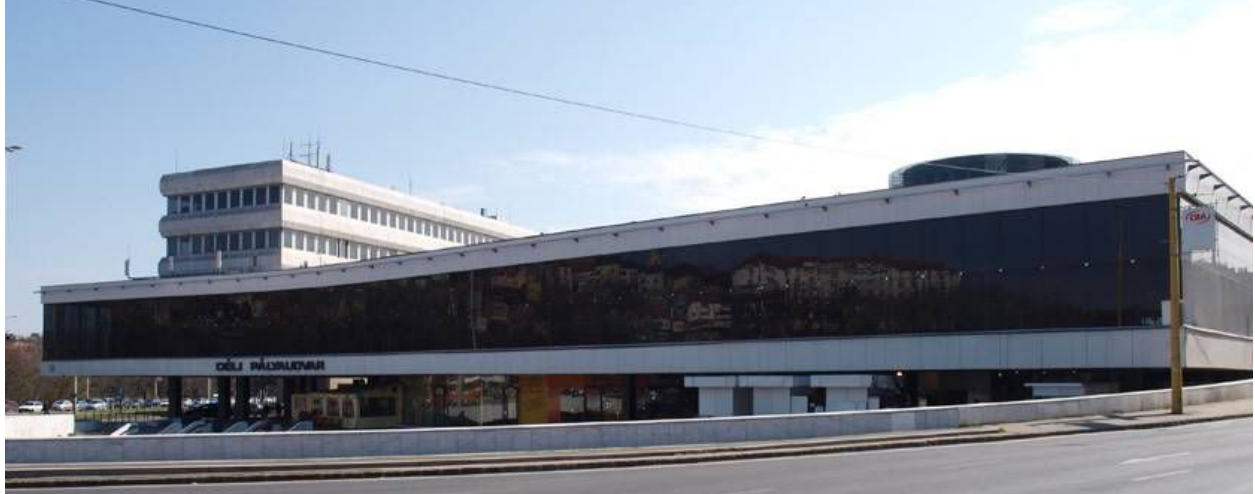
22.kép: Déli Pályaudvar teljes átépítése (1969)
