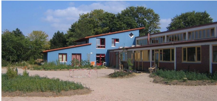
Műhelyé alakított csarnoképületek
