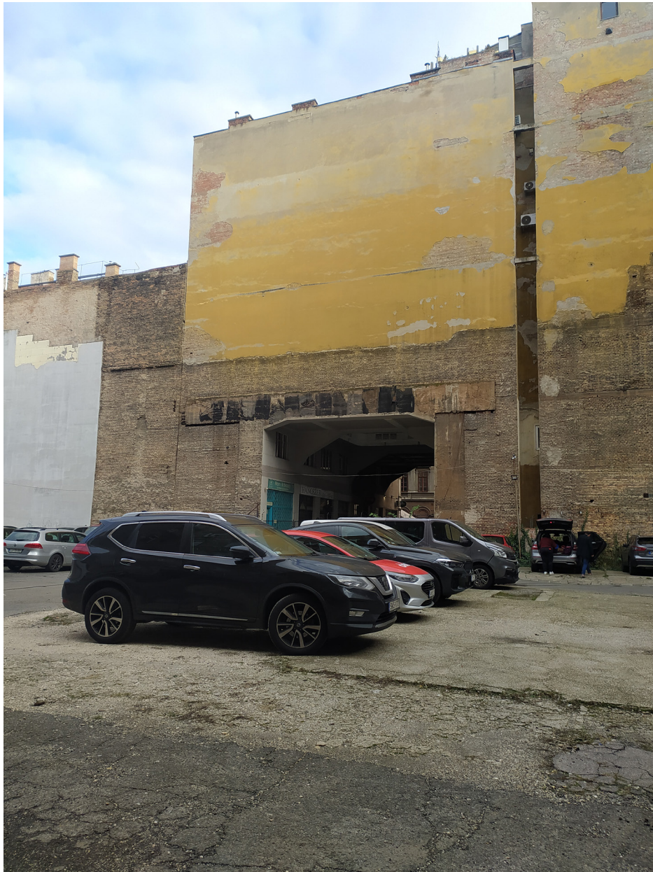
7 - RUMBACH SEBESTYÉN UTCA 8 FOGHÍJTELEK
