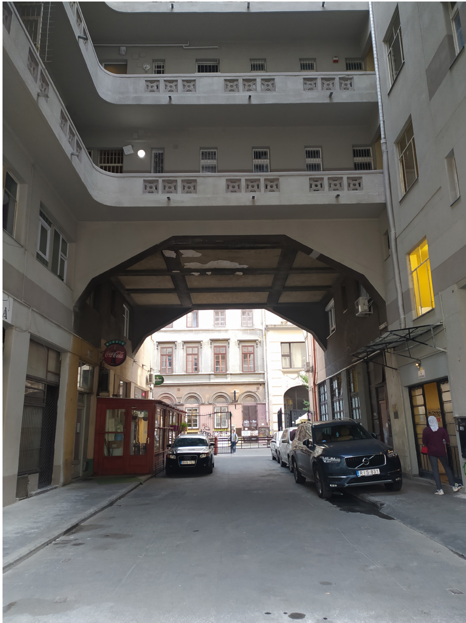
I - DOB UTCA ÉS RUMBACH SEBESTYÉN UTCAI FOGHÍJTELEK KÖZÖTTI ÁTJÁRÓ
