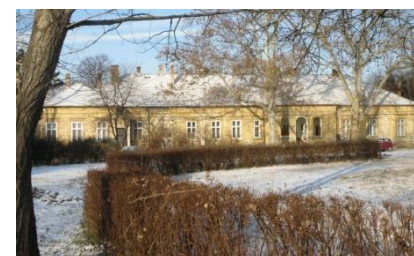
35. ábra IV. sz. telep kúriaépülete, 2010 (Forrás: saját felvétel)
