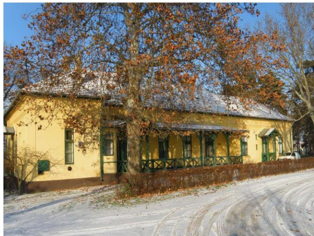
43. ábra II. sz. telep kúriaépülete
