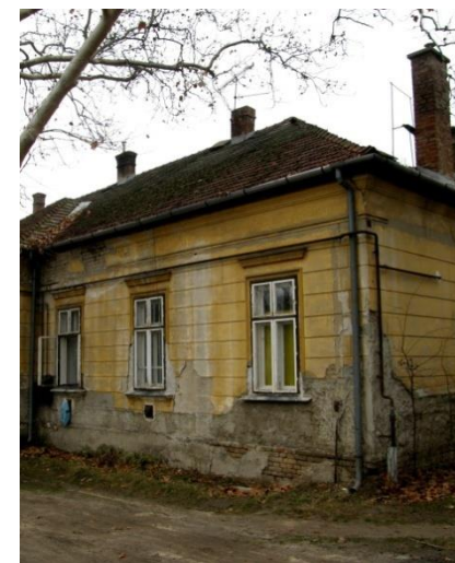
12. ábra Kúriaépület - nedvesedés okozta károk (Forrás: Dr. Fekete J. Csaba felvétele)
