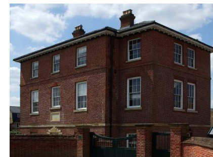
50. ábra A Palace House keleti szárnya ma (Forrás: newmarketracecourses.co.uk )
