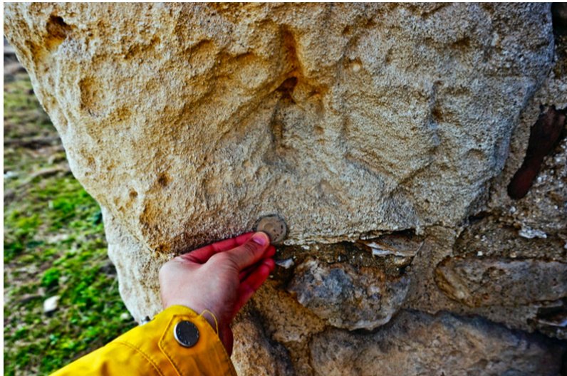
› 17. ábra: szemcsekipergés hatására lekerekítettre mállott kváderkő, a 15. Ábrán világoskékkel jelölt mállási forma
