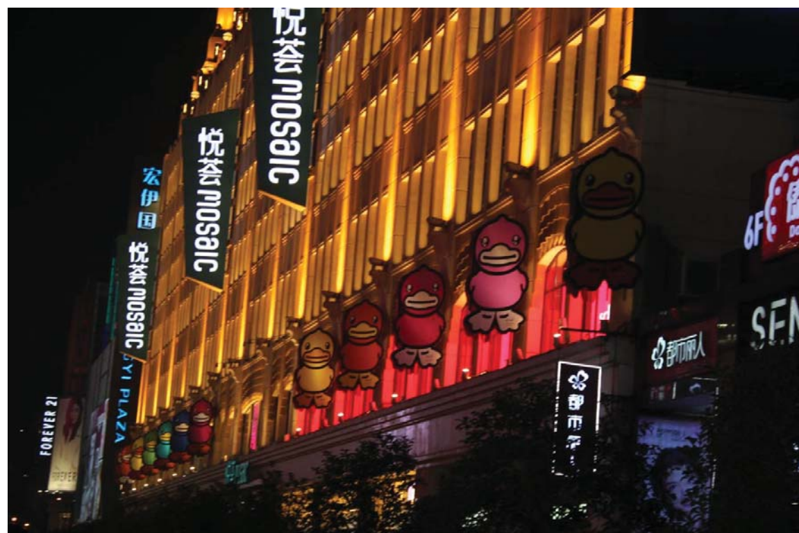
43.picture – 43.kép The commercial-façades A reklámhomlokzatok
