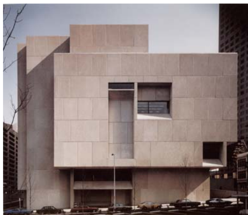
30. ábra / Az atlantai könyvtár homlokzata
