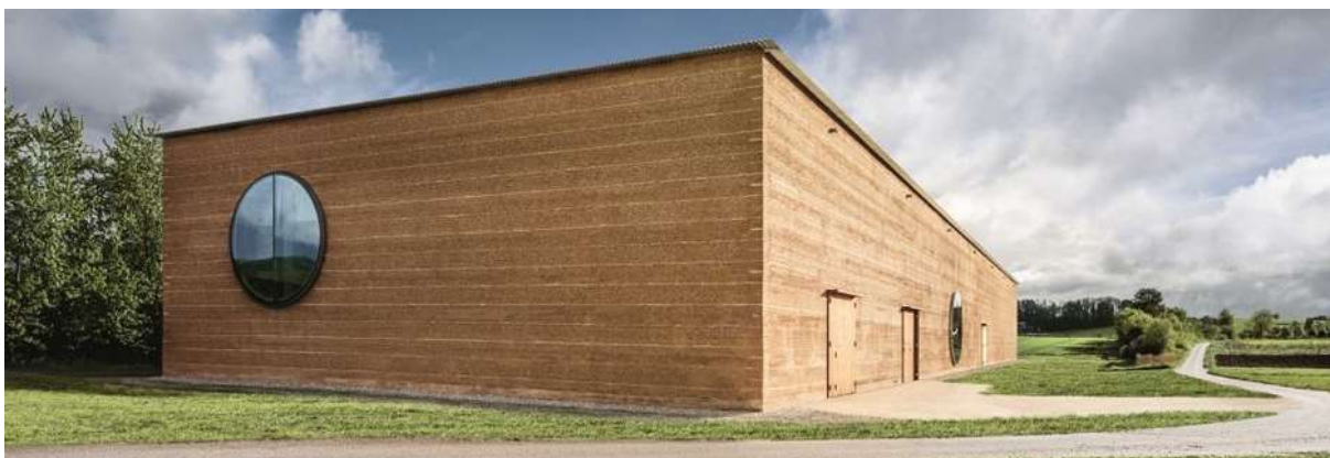
20. ábra A Ricola Kräuterzentrum vert vályogpanelekből készült épülete kész állapotban [30]
