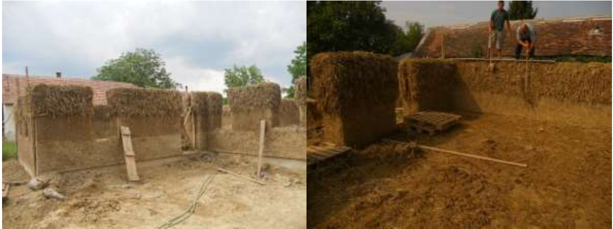
6. - 7. ábra Rakott sárfal készítése [19]
