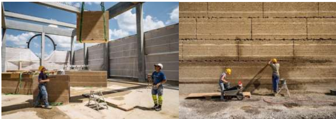
18. -19. ábra A Ricola Kräuterzentrum építése előregyártott vert vályogpanelekkal [30]
